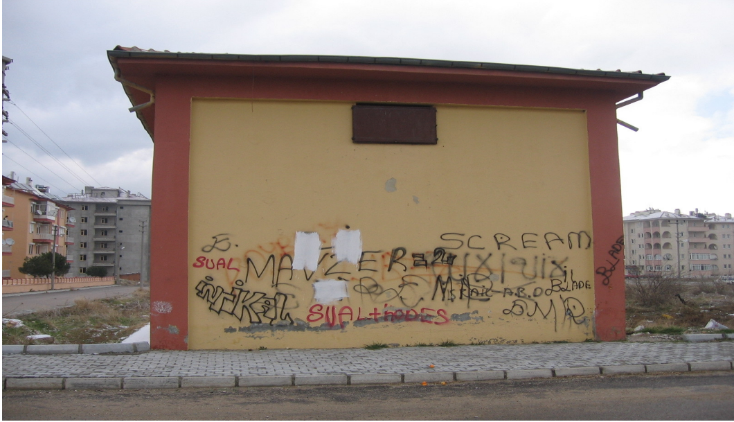
Resim 5. Vandalizm eylemine maruz kalmış elektrik trafosu (Isparta).
