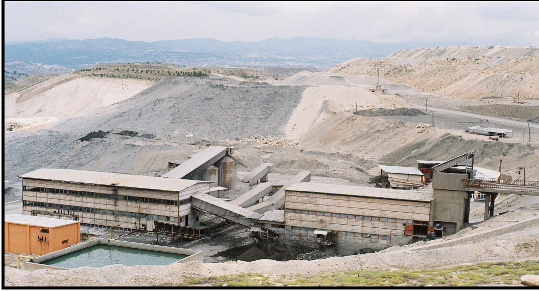
Fotoğraf 20. Hisarcık Konsantratör (Cevher Zenginleştirme)Tesisinden Görünüm
