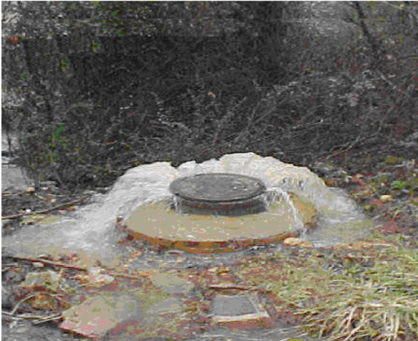
Foto 6: Atık yağ ve greslerin oluşturduğu blokajdan dolayı kanalizasyonda atık su taşkını Kaynak: www.cevreorman.gov.tr ,2006
