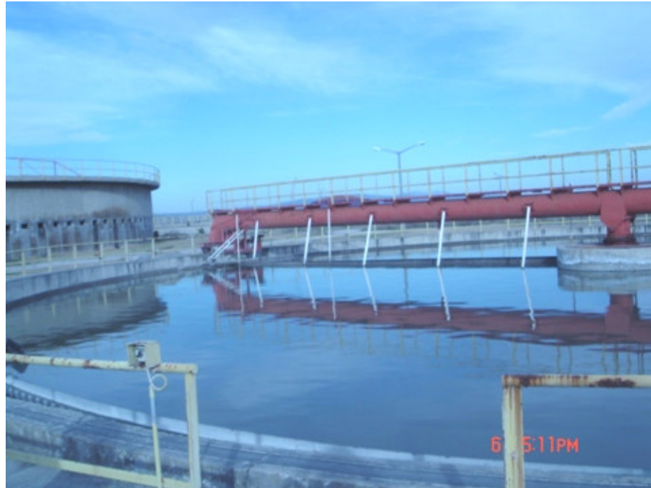
Foto 4: Atık su arıtma tesisinden bir görünüm
