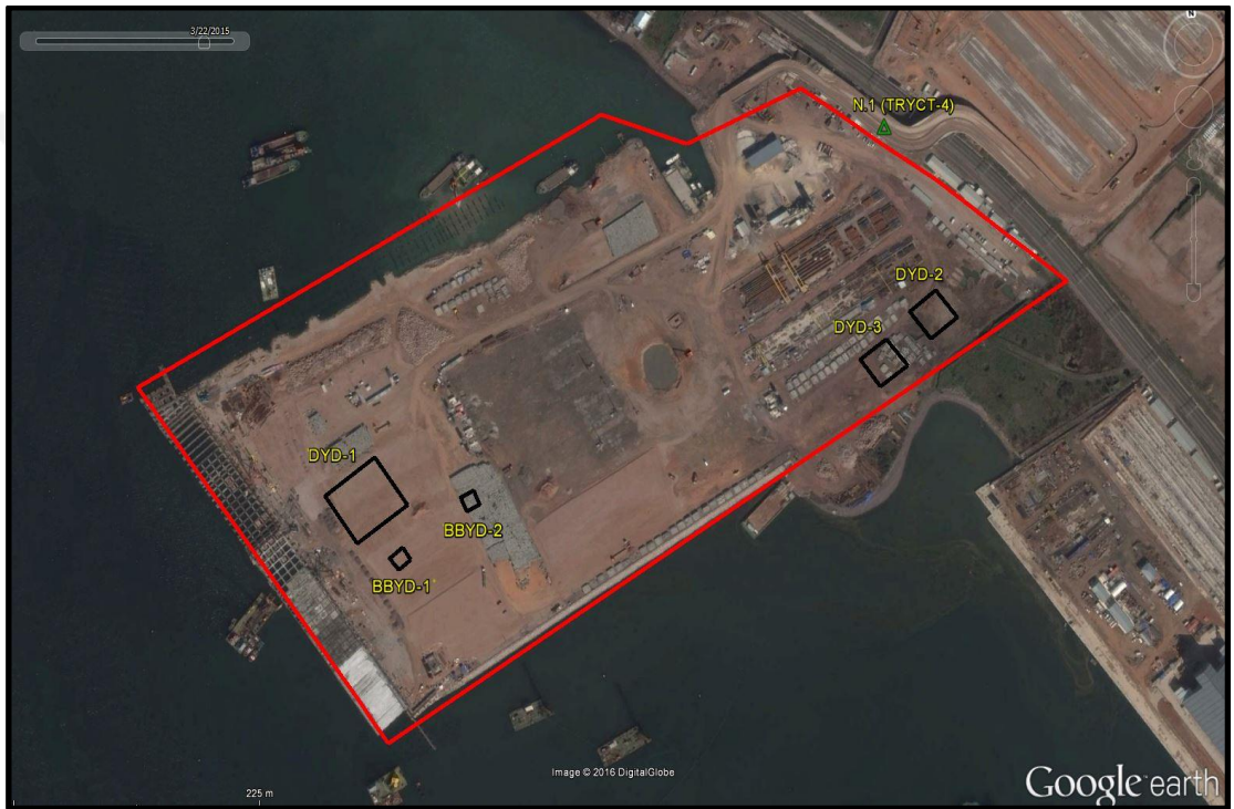
Şekil 6.2: Düşey Deformasyonu izlenen dolguların uydudan görünümü. (Nisan 2015) (BBYO: Beton Blok Yükleme Deneyi, DYO: Dolgu Yükleme Deneyi)
