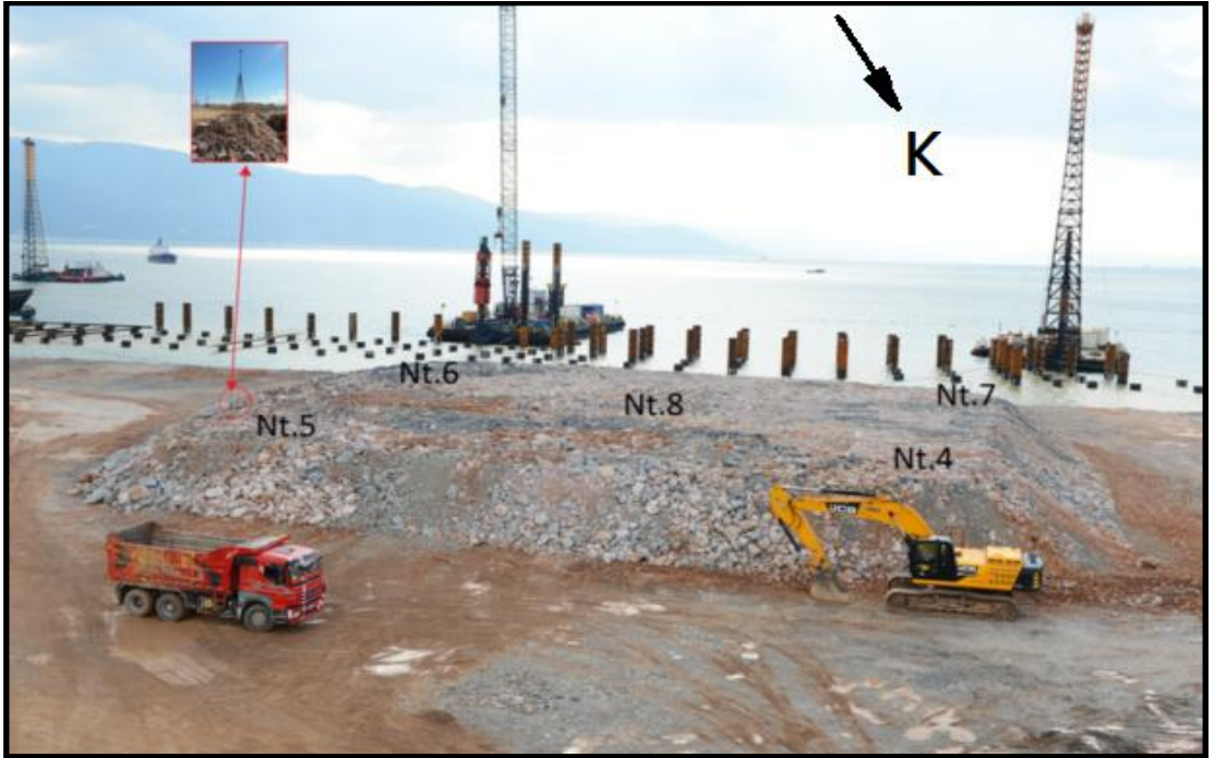
Şekil 6.4: Dolgu Yükleme Deneyi-1'in görünümü. (Nt.4: Nokta 4)
