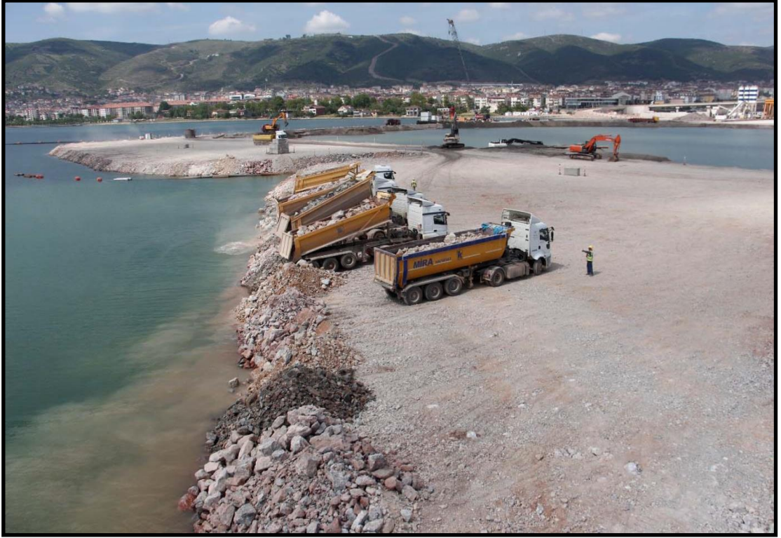
Şekil 4.2: 0,1-400 kg kaya dolgu malzemesiyle deniz dolgusu görünümü.
