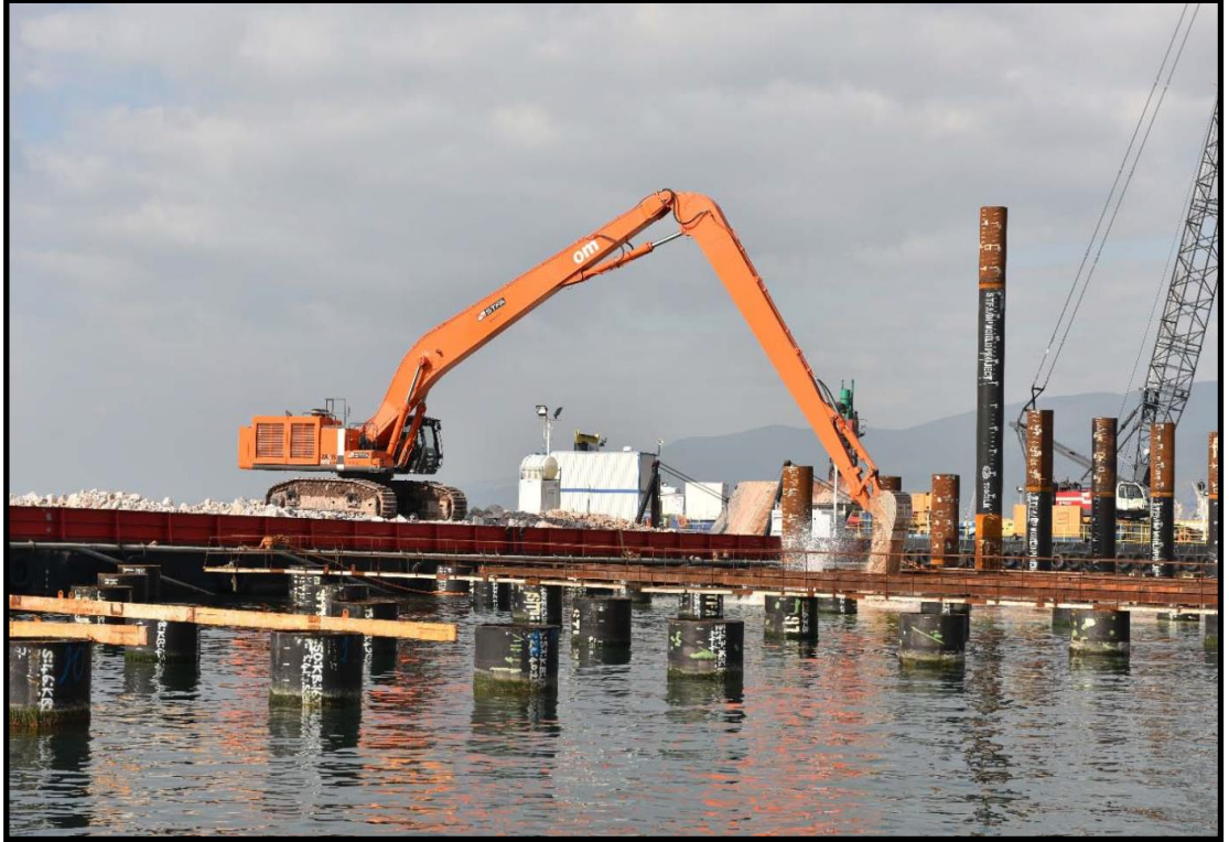
Şekil 3.3: Deniz dibi yumuşak kil ve balçık taramasını gerçekleştiren backhoe.
