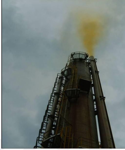
Şekil 2.1: Gübre üretimi yapan tesise ait bacadan görünen \text{NO}_x salınımı.
