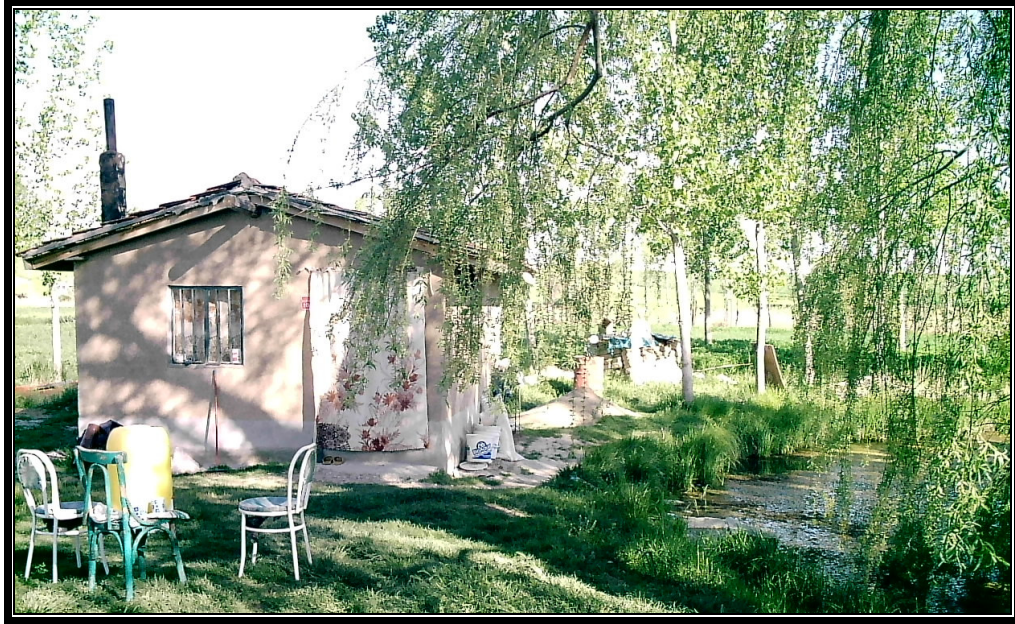
Fotoğraf 19. Hamamkaya Civarında Basit Bir Tarzda İnşa Edilen Balıkçı Kulübesi.
