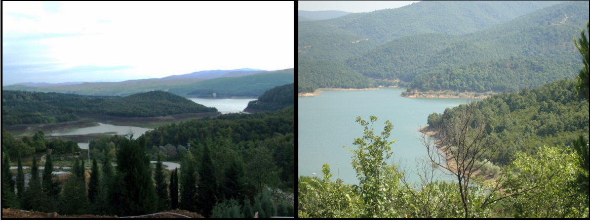
Foto 6: Gökçedere barajı (Kuzeye bakış).
