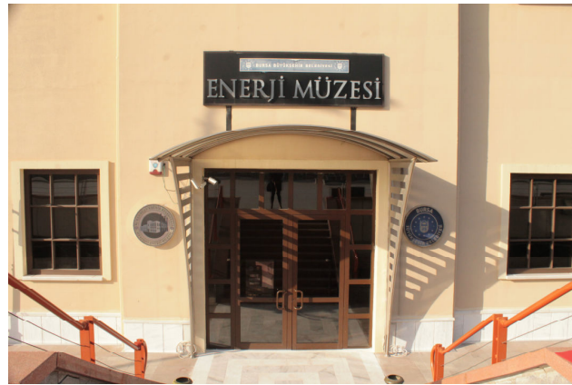
Şekil 2.54: Güç Merkezi Güney Cephesi Giriş Kapısı Restorasyon Sonrası.
