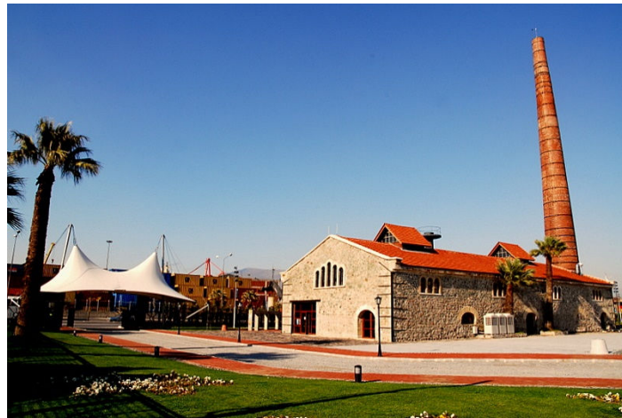
Şekil 1.8: Alsancak Hava Gazı Fabrikası.
