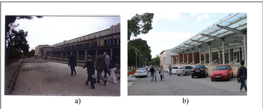
Şekil 2.30: Dokuma İplik İşletmesi Batı Cephesi a) Restorasyon Öncesi b) Restorasyon Sonrası.
