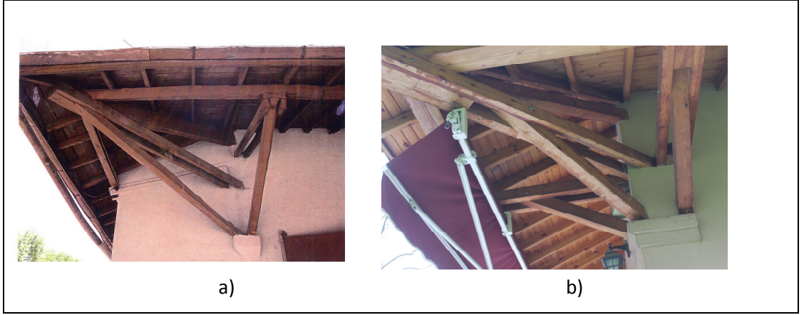
Şekil 2.81: Puantörlük Binası Giriş Üstü Ahşap Saçak a) Rekonstrüksiyon Öncesi b) Rekonstrüksiyon Sonrası.
