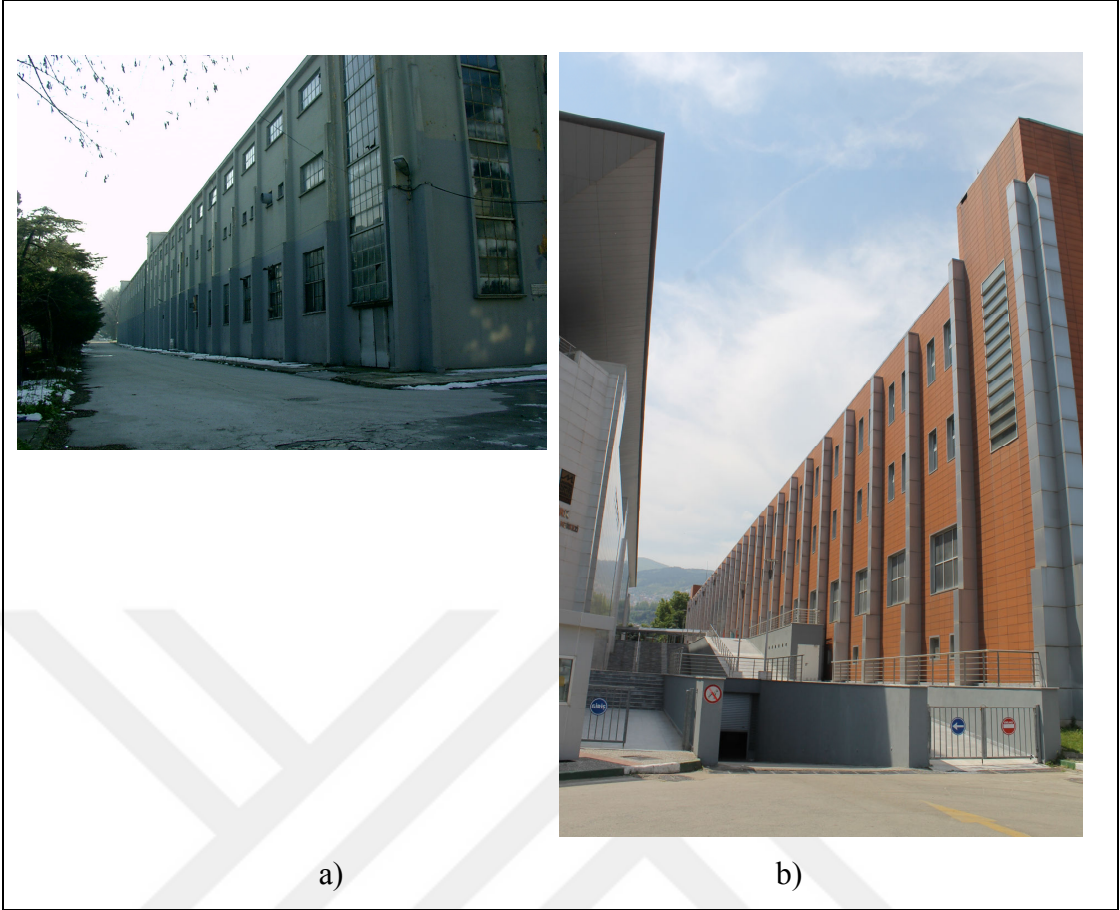
Şekil 2.36: Dokuma İplik İşletmesi Doğu Cephesi a) Restorasyon Öncesi b) Restorasyon Sonrası.
