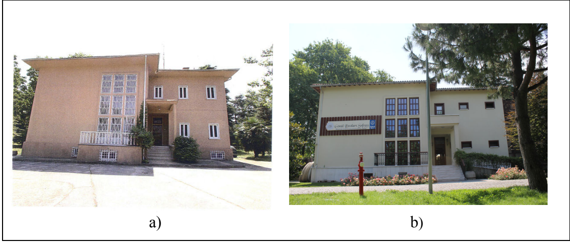
Şekil 2.58: Müdür Evi Kuzeybatı (Giriş) Cephesi a) Restorasyon Öncesi b) Restorasyon Sonrası
