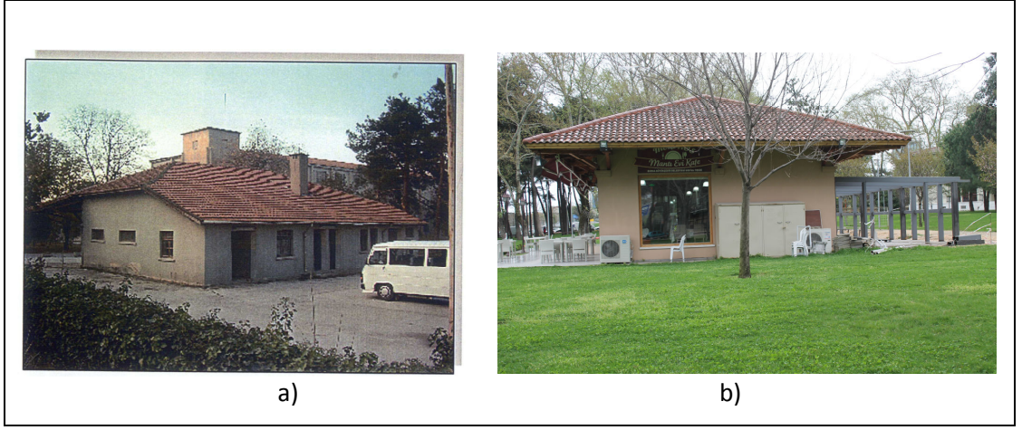
Şekil 2.84: Puantörlük Binası a) Rekonstrüksiyon Öncesi Güney Cephesi b) Rekonstrüksiyon Sonrası Batı Cephesi.
