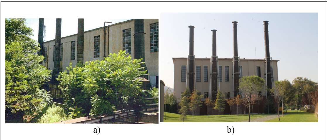
Şekil 2.51: Güç Merkezi Doğu Cephesi a) Restorasyon Öncesi b) Restorasyon Sonrası.
