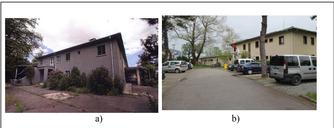
Şekil 2.77: T.-E.M.-R-T.K Güney Dış Cephesi a) Restorasyon Öncesi b) Restorasyon Sonrası.
