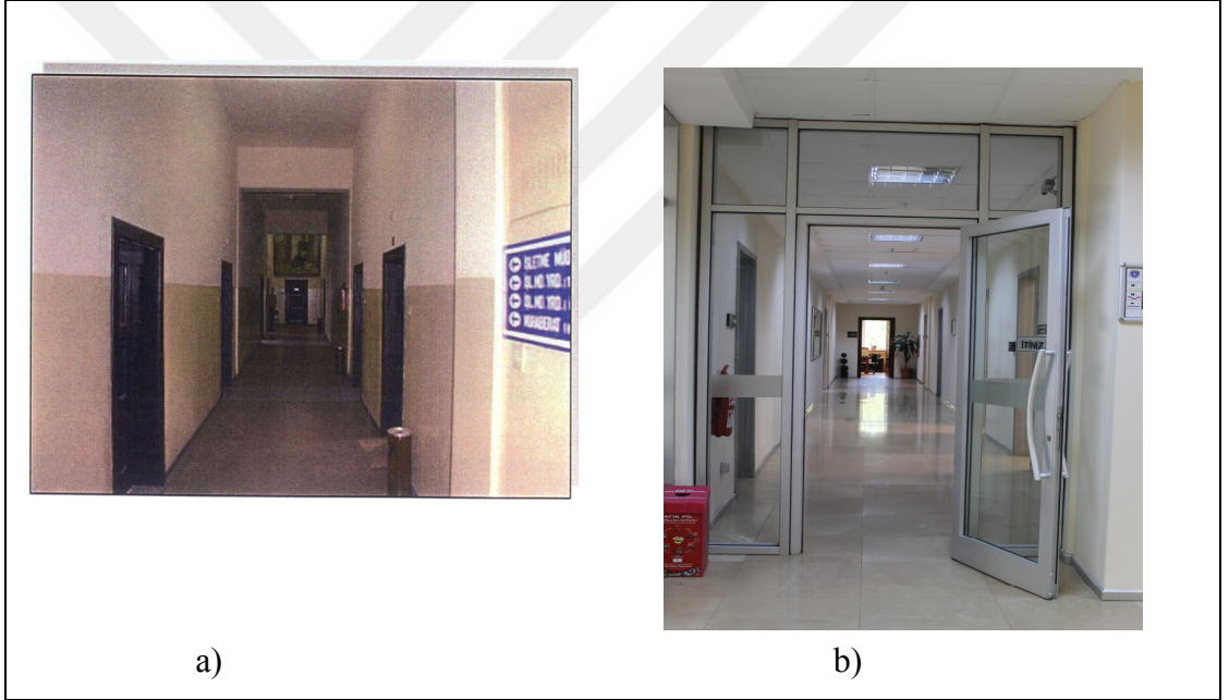
Şekil 2.19: Dokuma İplik İşletmesi Müdüriyet Bölümü Zemin Kat Ofis Koridoru a) Restorasyon Öncesi b) Restorasyon Sonrası.
