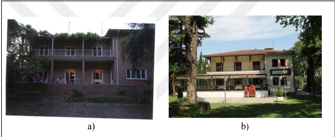
Şekil 2.59: Müdür Evi Güneydoğu Cephesi a) Restorasyon Öncesi b) Restorasyon Sonrası
