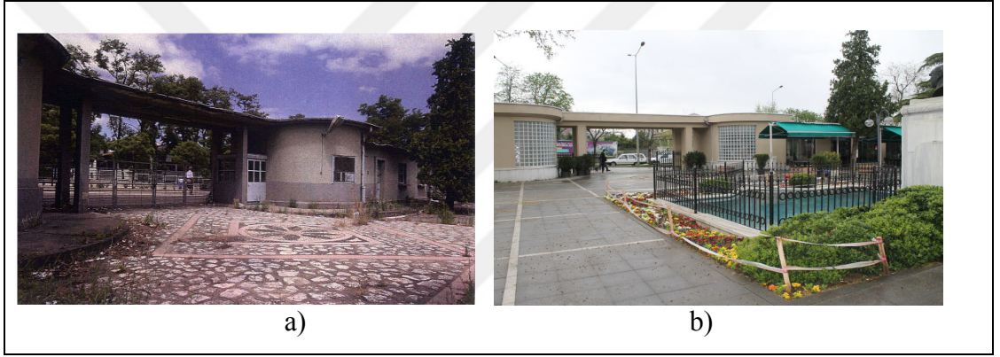
Şekil 2.73: T.-E.M.-R-T.K Avlu Doğu Cephesi a) Restorasyon Öncesi b) Restorasyon Sonrası
