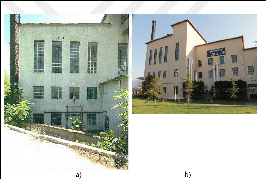
Şekil 2.48: Güç Merkezi Kuzey Cephesi a) Restorasyon Öncesi b) Restorasyon Sonrası.
