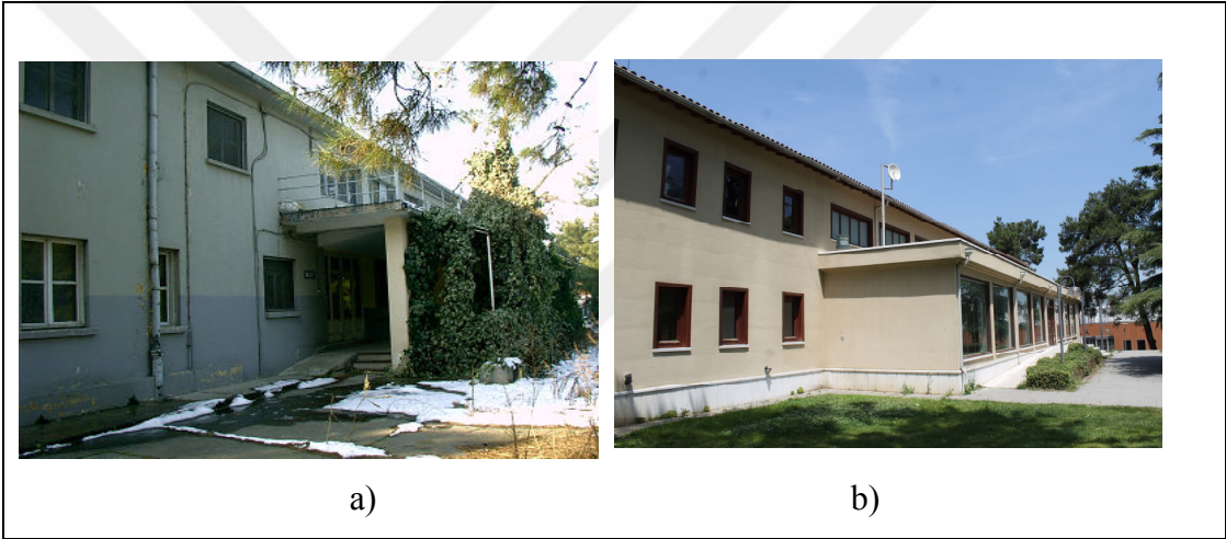
Şekil 2.76: T.-E.M.-R-T.K Doğu Dış Cephesi a) Restorasyon Öncesi b) Restorasyon Sonrası.
