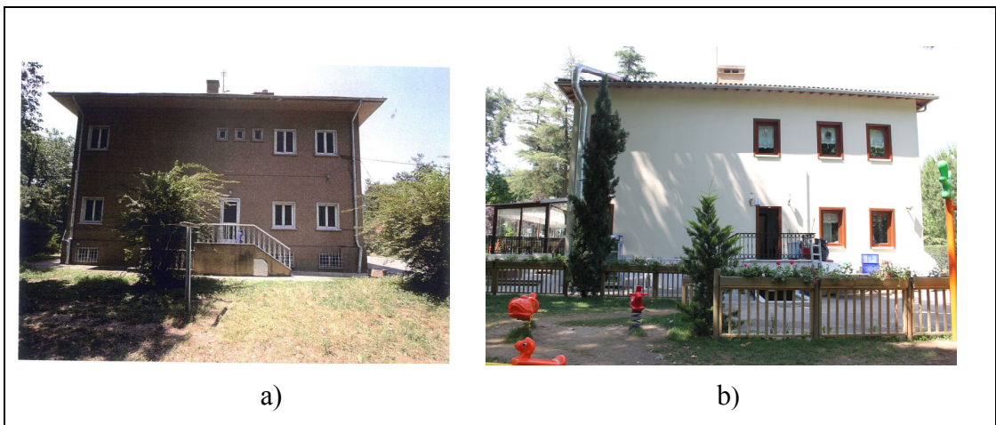
Şekil 2.60: Müdür Evi Güneybatı Cephesi a) Restorasyon Öncesi b) Restorasyon Sonrası.
