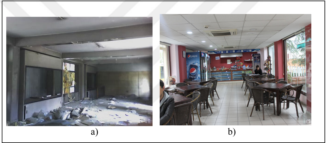
Şekil 2.70: T.-E.M.-R-T.K Tüketim Kooperatifi a) Restorasyon Öncesi b) Restorasyon Sonrası Kafeterya.
