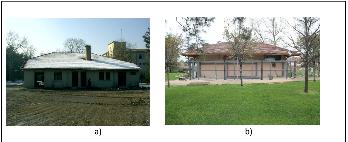
Şekil 2.83: Puantörlük Binası a) Rekonstrüksiyon Öncesi Doğu Cephesi b) Rekonstrüksiyon Sonrası Güney Cephesi.
