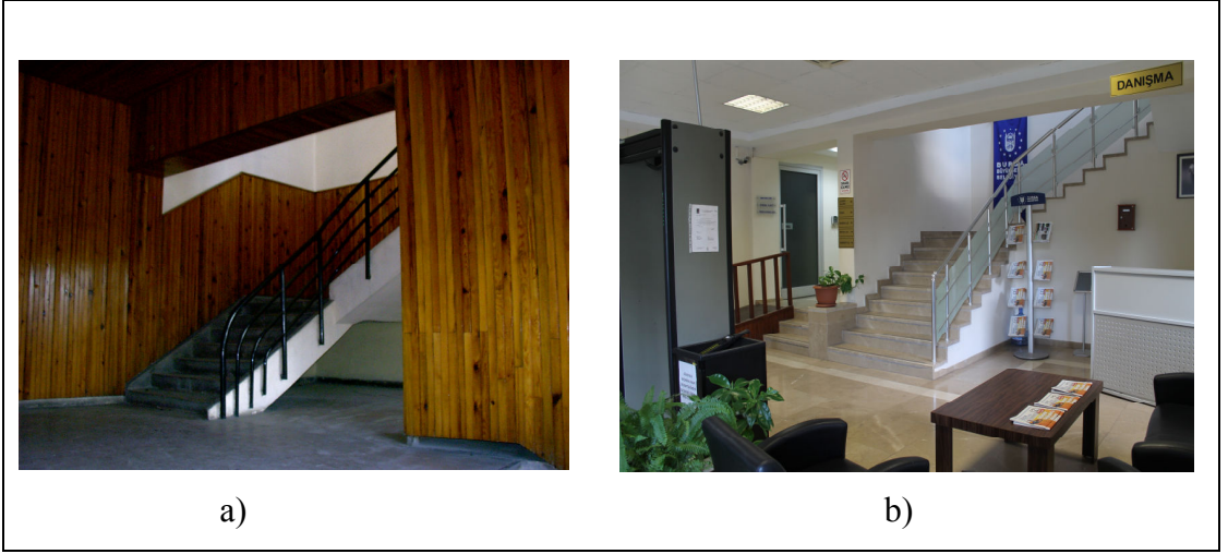
Şekil 2.18: Dokuma İplik İşletmesi Müdüriyet Bölümü Bodrum Kat Girişi a) Restorasyon Öncesi b) Restorasyon Sonrası.
