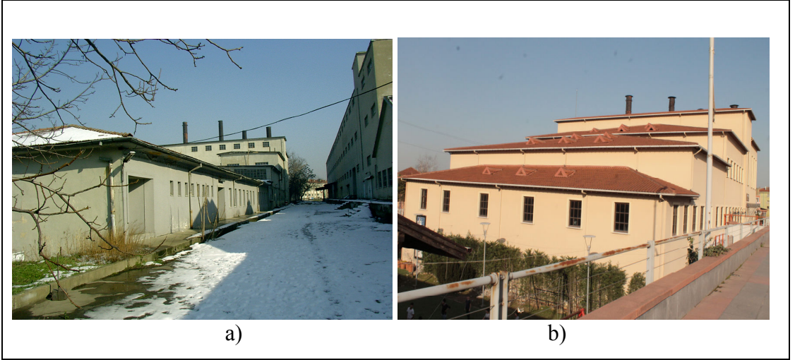
Şekil 2.52: Güç Merkezi Güney Cephesi a) Restorasyon Öncesi b) Restorasyon Sonrası.
