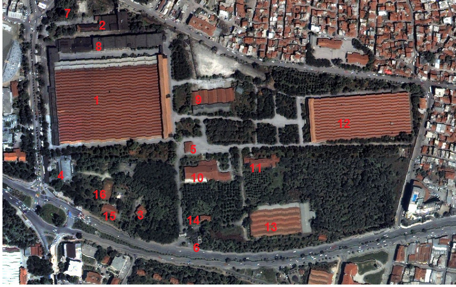
Şekil 2.8: Bursa Merinos İplik ve Dokuma Fabrikası Restorasyon Öncesi Yerleşimi. 1.Dokuma İplik İşletmesi 2. Güç Merkezi 3. Müdür Evi 4. Tabldot 5. Puantörlük 6. Su Kulesi 7. Soğutma Kulesi 8. Ham Madde Ambarları 9. Salaş Ambarları 10. İşçi Yemekhanesi 11. Kreş 12. Dokuma-Apre İşletmesi 13. Hazır Giyim İşletmesi 14. Lojman 15. Lokal 16. Misafirhane.
