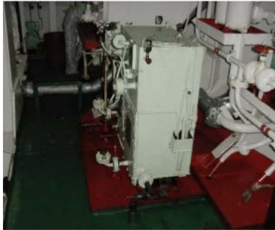
Şekil 2.5:Yağlı su seperatörü, (Oily Water Separator, OWS).
