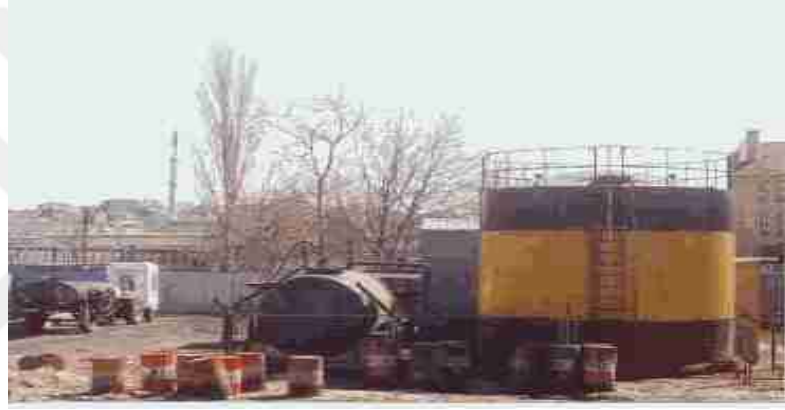
Şekil 2.9: Gemilerden alınan sintinelerin toplanıp dinlendirildiği tanklar, Haydarpaşa.
