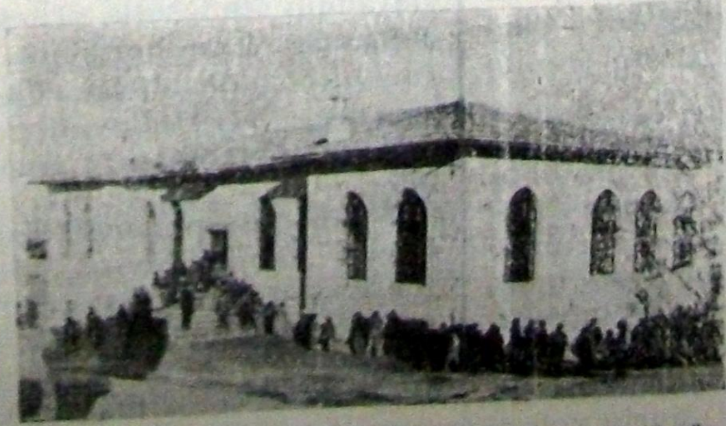
Yeni köy okullarımızdan diğer bir görünüş
