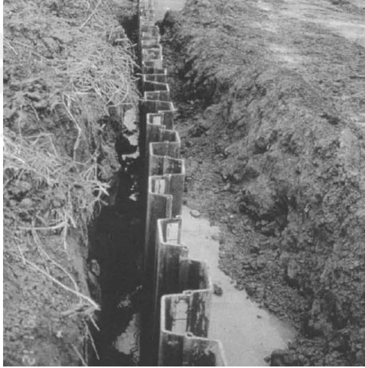
Şekil 3.2. Çelik palplanş kazık yönteminin fotoğrafı (Ou, 2006)
