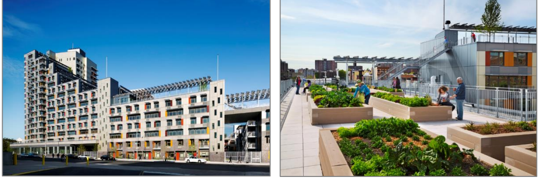
Şekil 3.27: Via Verde a) görünüşü ve b) çatısı.
