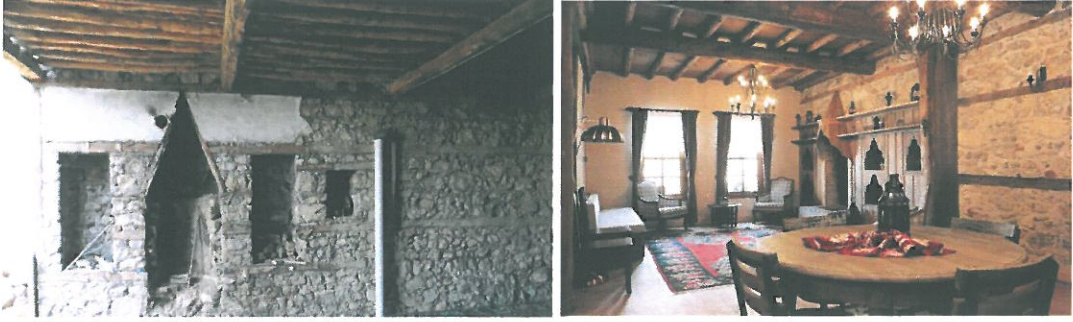
Şekil 3.22. Eskiciler Konağı kahvaltı salonu onarım öncesi ve sonrası (Foto Savaş)
