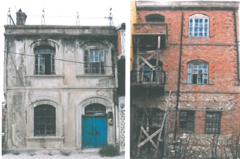
Şekil 3.29. Envanter no:7, Ada:188 Parsel: 8 tescilli yapı (Kişisel Arşiv)
