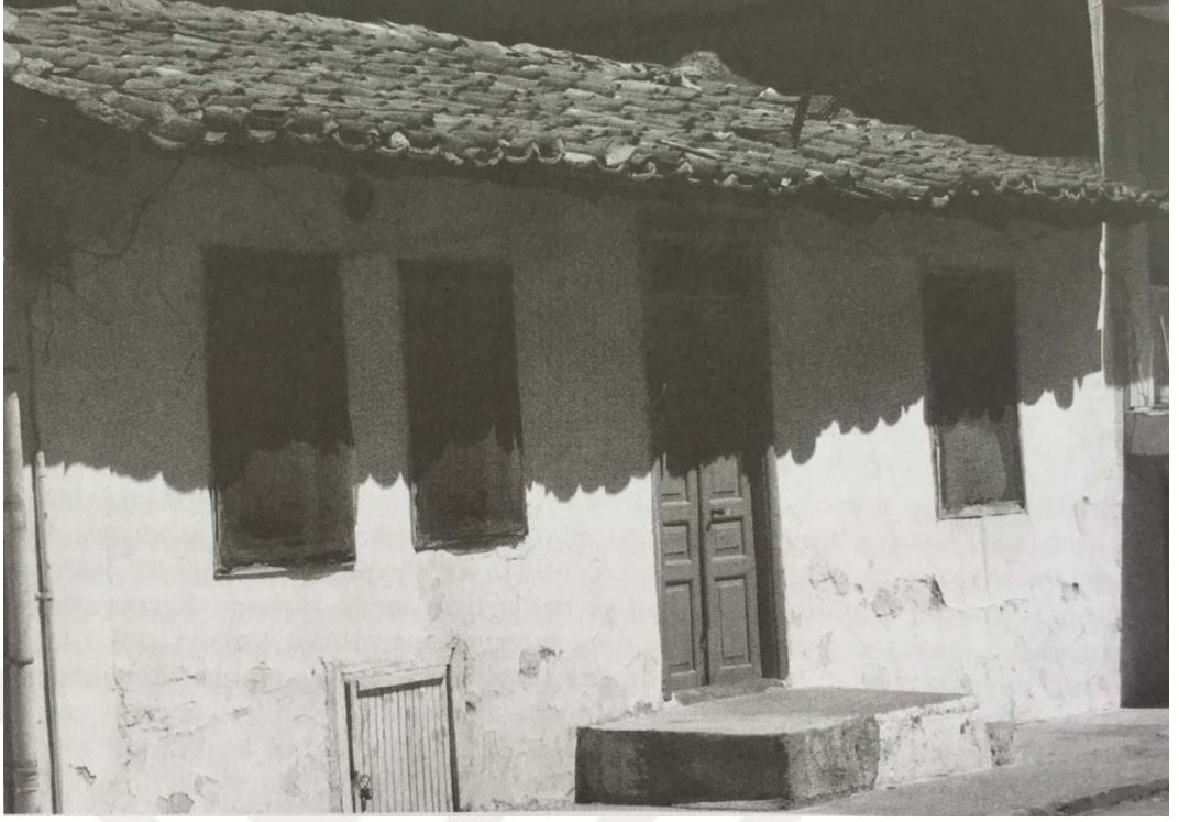
Şekil 4.3. Girit Adası'ndan gelen soydaşlarımıza Şarampol mevkiinde yaptırılan tek katlı evler (Çimrin, 2006)
