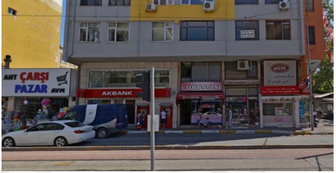
Şekil 5.5. Proje öncesi Şarampol Caddesi cephe görünümü, 2014 (Google, 2018)
