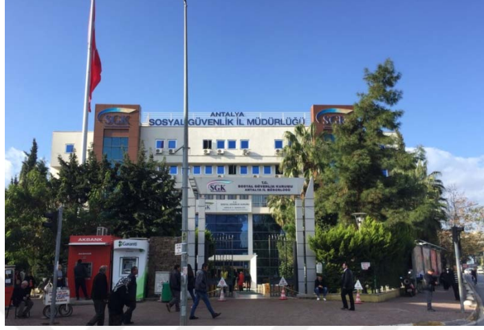
Şekil 4.16. Antalya Sosyal Güvenlik İl Müdürlüğü Binası (Gülçin Borucu kişisel arşivi, 2019)
