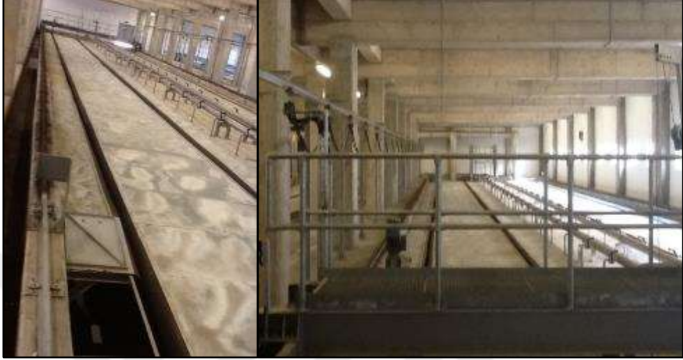
Şekil 4.4: Havalandırmalı kum ve yağ tutucu görüntüleri.
