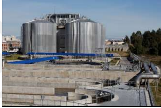
Şekil 4.3. Anaerobik çamur çürütücüler.
