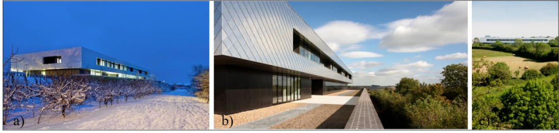
Şekil 4.5 : Circle Hospital in Bath, İngiltere, Norman Foster&Partners, a) Dış Görünüş, b) Cephe Detayı, c) Yapı Doğa Etkileşimi.
