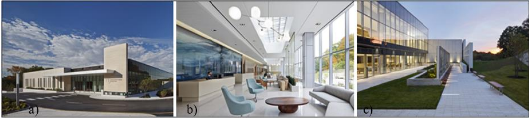
Şekil 4.12 : Memorial Sloan Kettering Cancer Center, Ewing Cole, a) Dış Görünüşü, b) Lobi Dış Mekan Görsel Etkileşim, c) Dış Bahçe .
