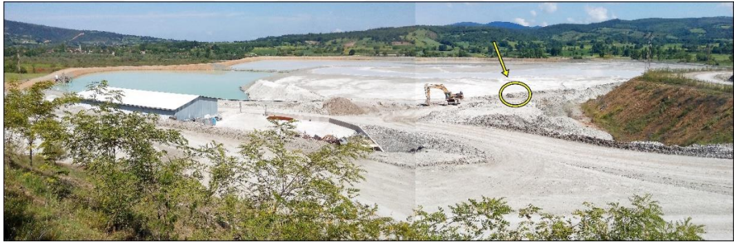
Şekil 2.6: Kestelek Atık Göleti Genel Görünümü ve Örnekleme Noktası.
