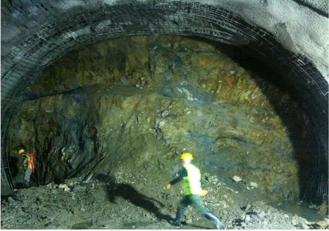
Şekil 4.10. Km:2+129,95 Peron Tüneli kazı aynası
