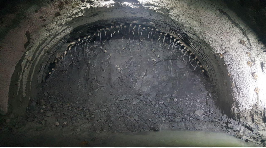
Şekil 4.11. Km: 2+165,55 Peron Tüneli kazı aynası
