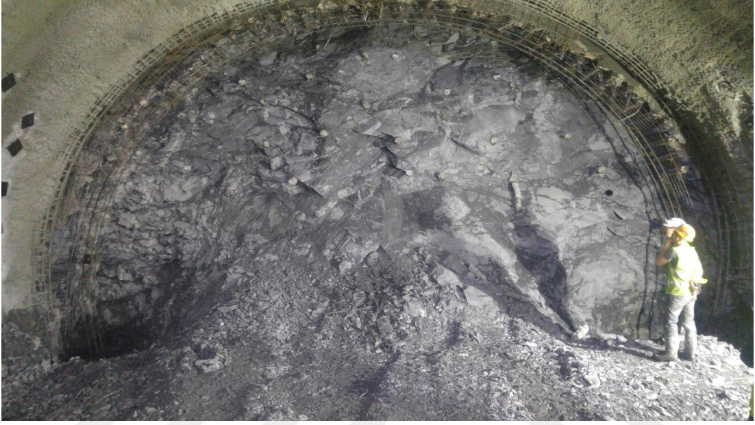
Şekil 4.9. Km:2+158,66 Peron Tüneli kazı aynası
