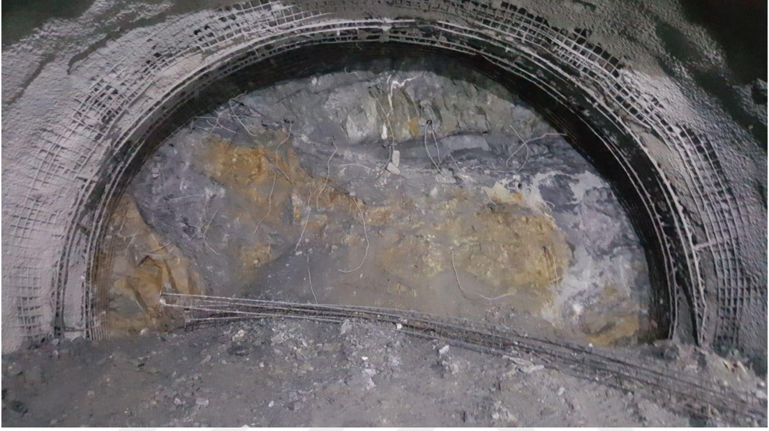
Şekil 4.8. Km:2+123,46 Peron Tüneli kazı aynası
