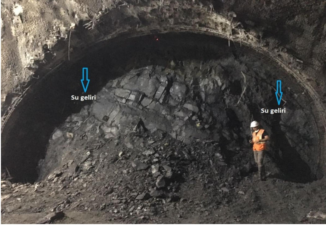
Şekil 4.12. Km: 2+108,11 Peron Tüneli kazı aynası
