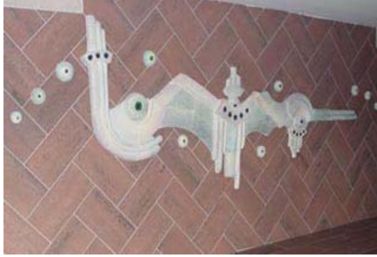
Resim 37: Seramik pano örneđi, S.D.Ü. Rektörlük Binası İç Duvarı
