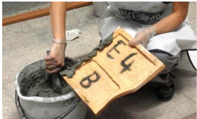
Resim 65: Yüzeye Serakol Uygulama
