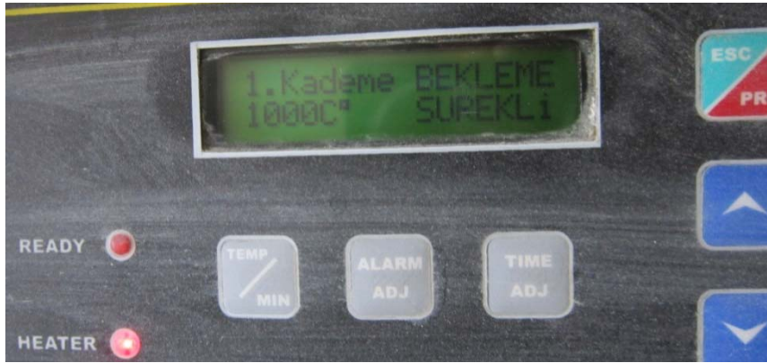
Resim 11. Döküm öncesi manşetin sıcaklığı ısıtma fırınında 1000°C'ye yükseltilmesi
