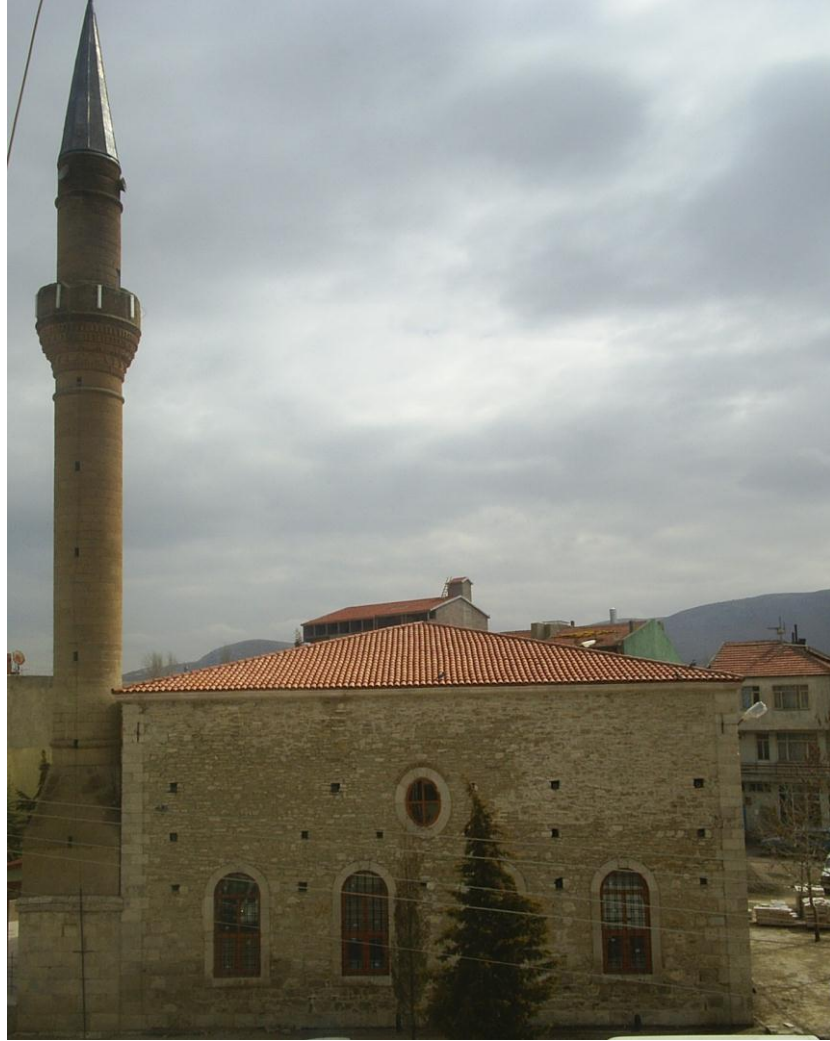
Şekil 3. Abdülgaffar Camisi Dış Cephe Görünümü. (Aslan 2011 )
