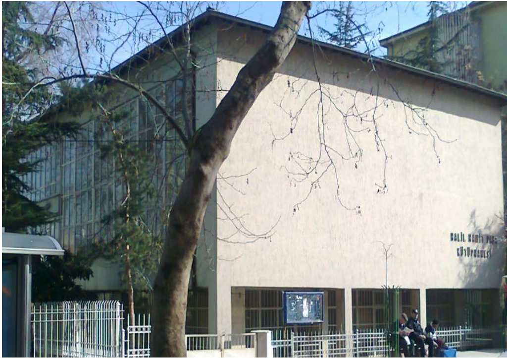
Şekil 1: Isparta Halil Hamit Paşa Kütüphanesi Eski Binası (Falak; 2013).
