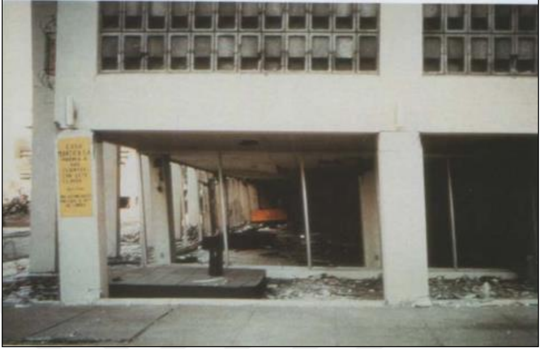
Şekil 2.5: Komşu katlar arası dayanım düzensizliği.
