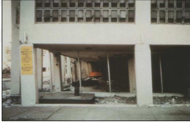
Şekil 2.29: B2 türü düzensizlik durumu.
