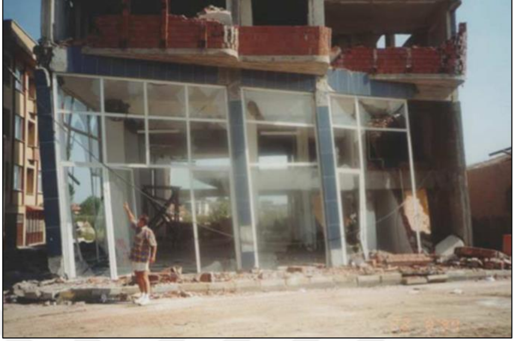
Şekil 2.17: Komşu katlar arası dayanım düzensizliklerine örnek.
