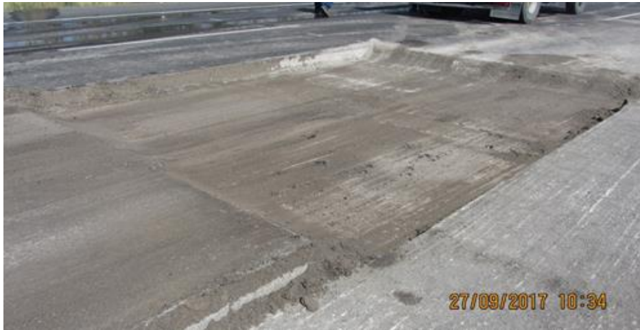
Şekil 3.2. Deney numunesi için kazınan yol kesimi
