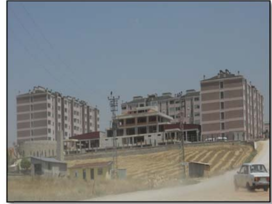
Foto 3: Gazlıgöl'de Yapılan Yeni Termal Otel
