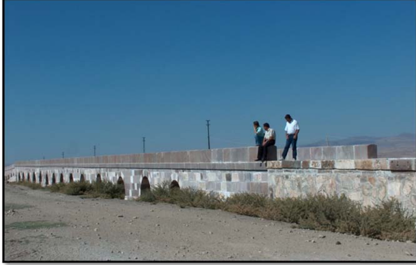
Foto 36: Bolvadin- Kırgöz Köprüsü (Foto: Mehmet Ali Özdemir)
