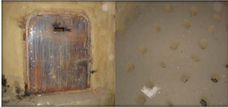
Şekil 56: Sıcaklığın dışarı çıkmaması için kapağı saçtan yapılmış fırın ve ısının fırın içine yayılması için oluşturulan delikler (Korkmaz,2016).
