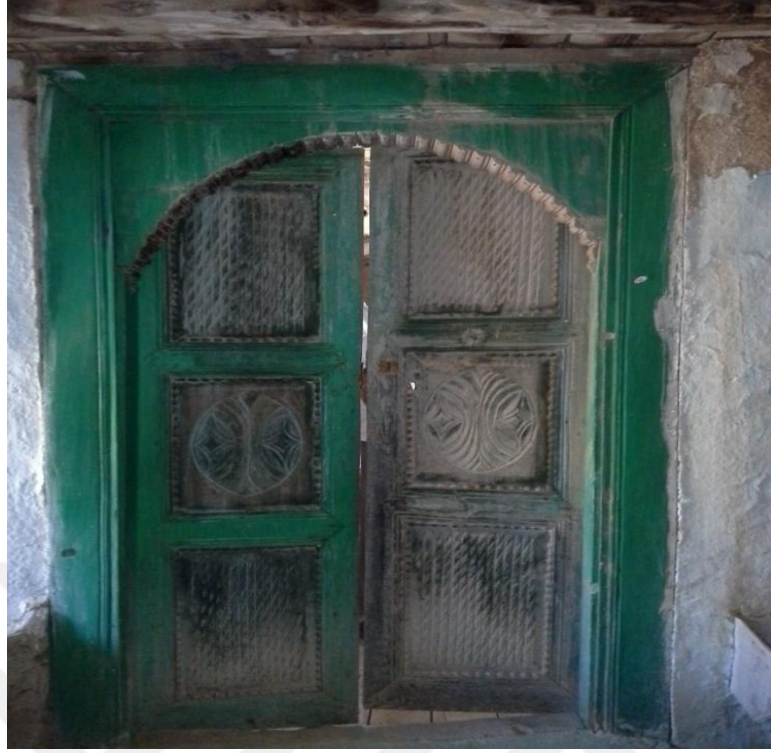
Şekil 29. : Çift Kanatlı Ahşap Kapı (Polat, 2014).
