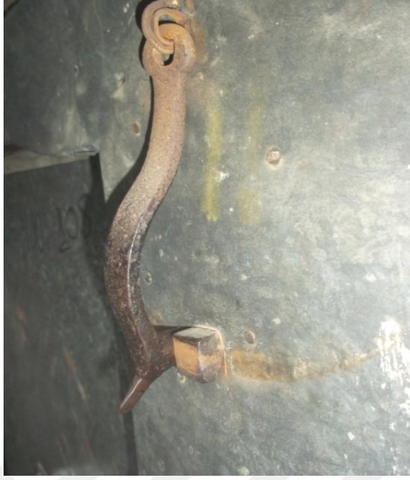
Şekil 68. : Ters “S” Kıvrımlı Kapı Tokmağı (Polat, 2015).
