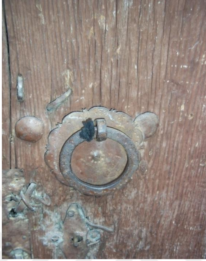
Şekil 90. : Kapı Halkası (Polat,2014)
