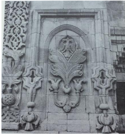
Şekil 40. : Erzurum Çifte Minareli Medrese Portal tezyinatı detayı
