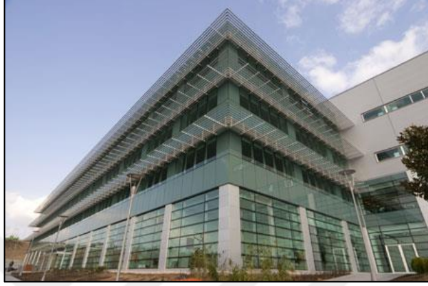
Şekil 4.21: Gölgeleme yapmak için uygulanan güneş kırıcı elemanları.
