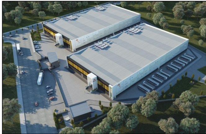
Şekil 4.30: Star Of Bosphorus Data Center-Tuzla binası.
