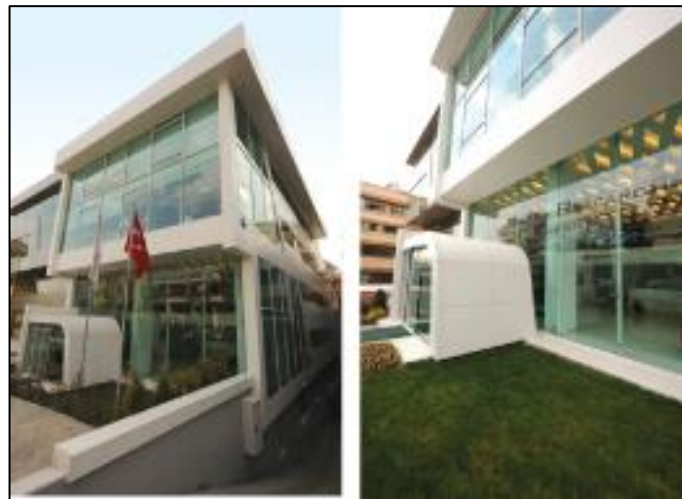
Şekil 4.26: Method Research Company Binası.
