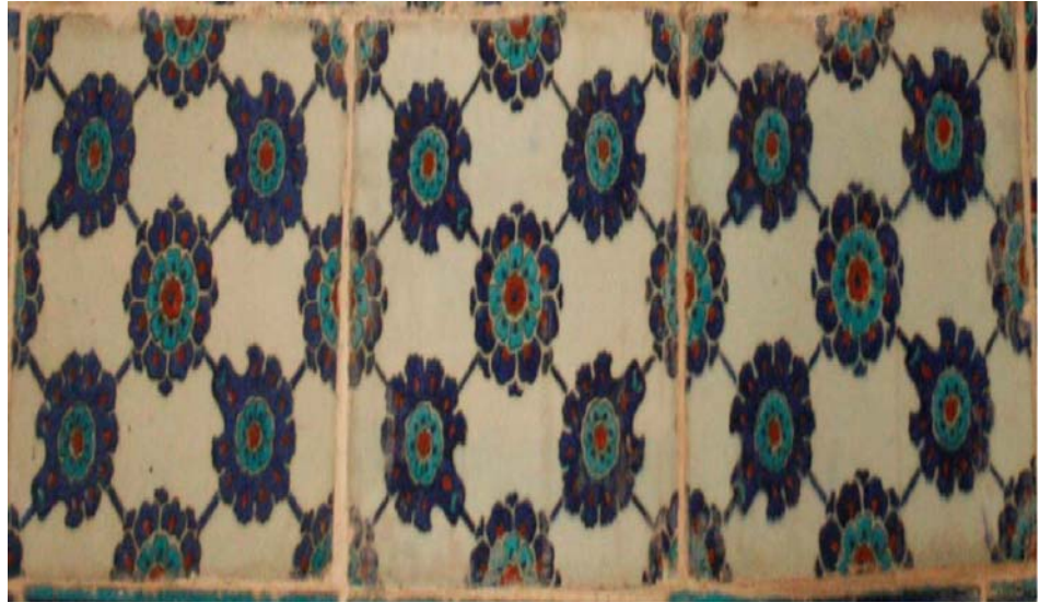
Resim 2.115: Kadınlar Mahfili Giriş Kapısı Duvarından Detay (İslamoğlu, 2010)
