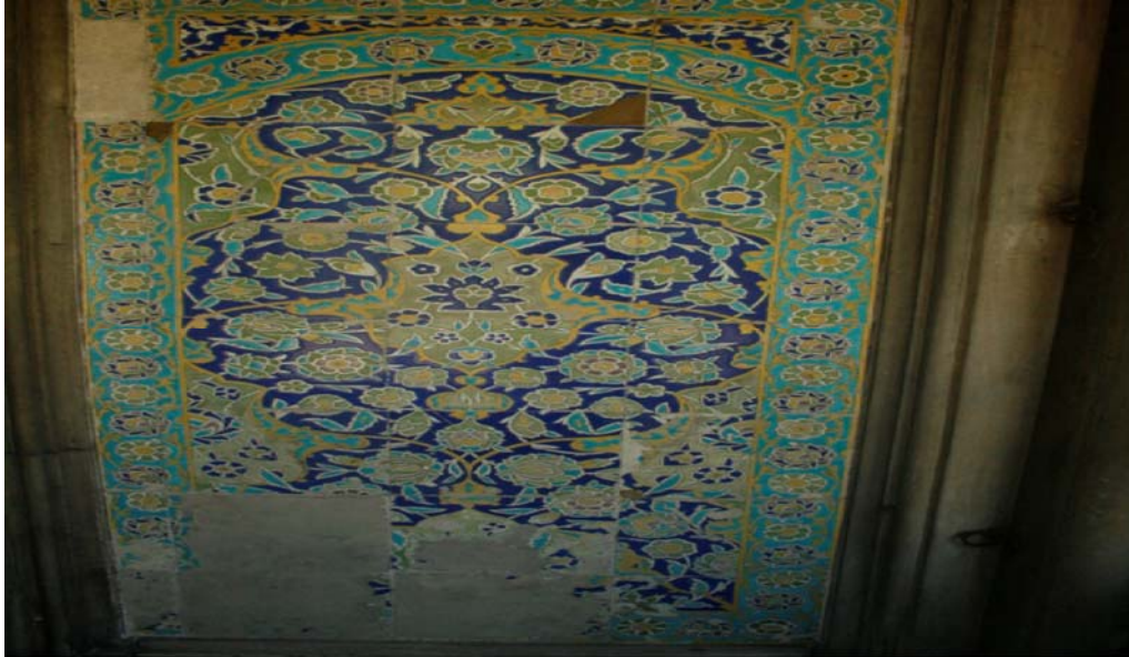
Resim 2.56: Revak kısmında sağ tarafta bulunan pano (İslamoğlu, 2010)
