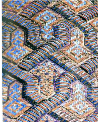
Şekil 18. : Erzurum Yakutiye Medresesi Mimarisindeki Sırlı Tuğla Süslemesi (Kaynak: Aker, 2010:5)
