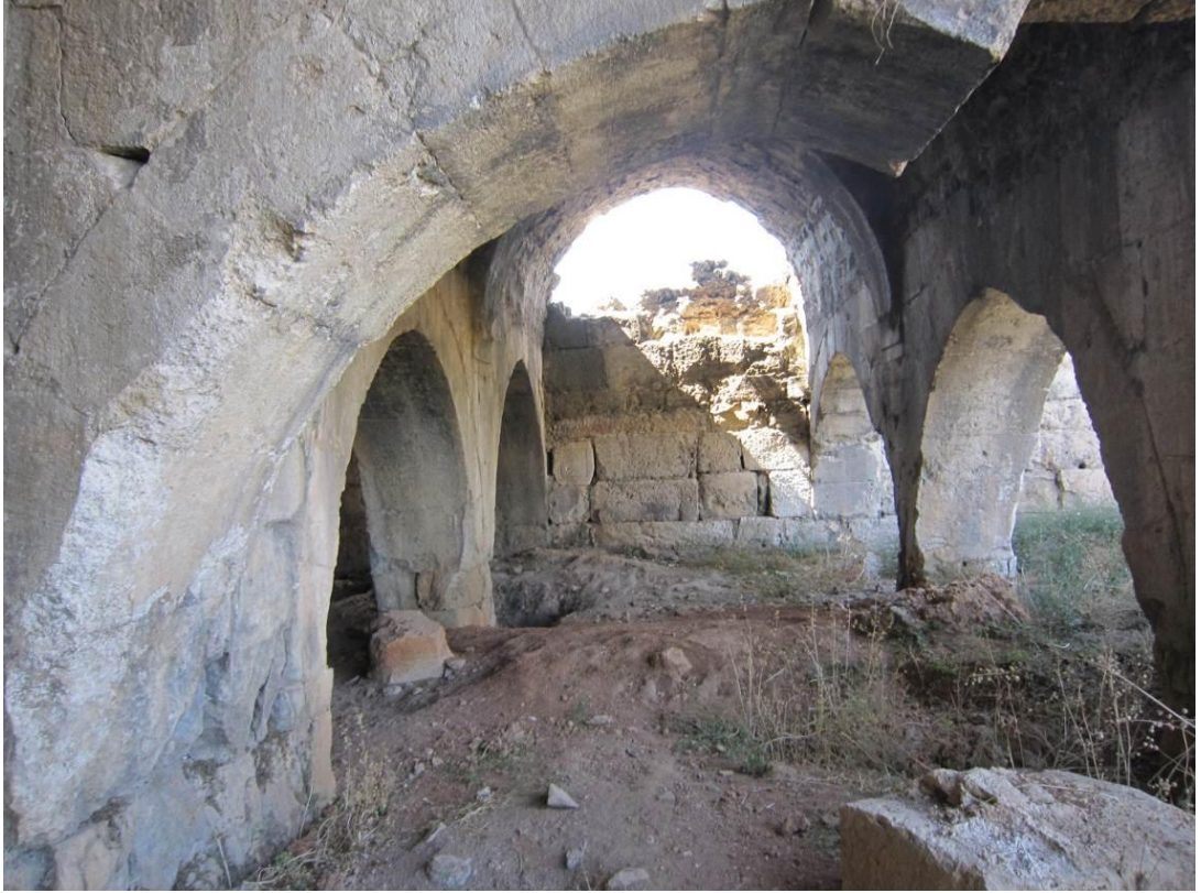
Levha:42 Emdir Han duvarlarındaki taş düşmeleri ve defincilerce açılan çukurlar (2011)
