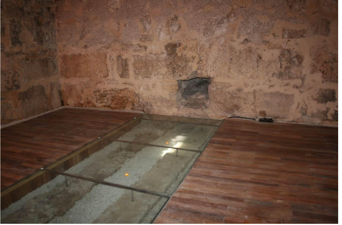
Levha:51 Kırkgöz Han giriş eyvanının batısındaki mekanda bulunan kanal (2011)
