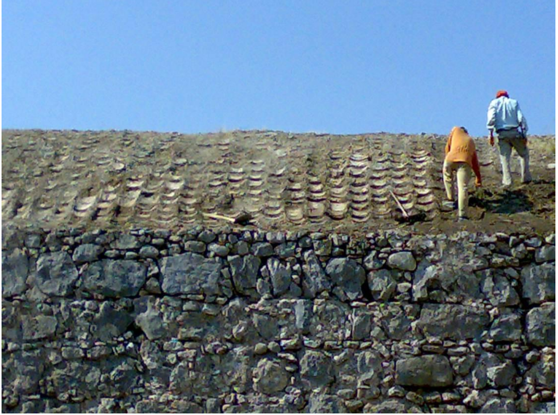
Levha:57 Kırkgöz Han üst örtüsünde onarım sırasında görülen kiremit kaplama (2006)
