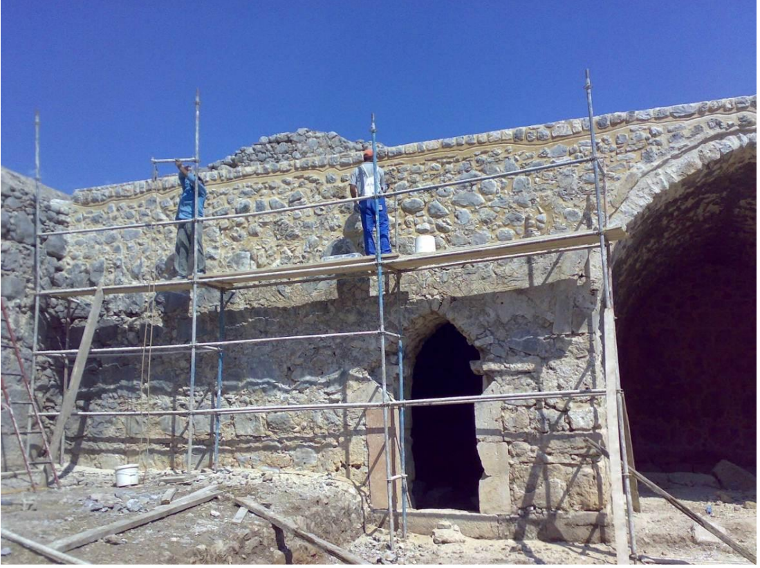
Levha:63 Kırkgöz Han beden duvarlarında yapılan derz çalışması (2006)
