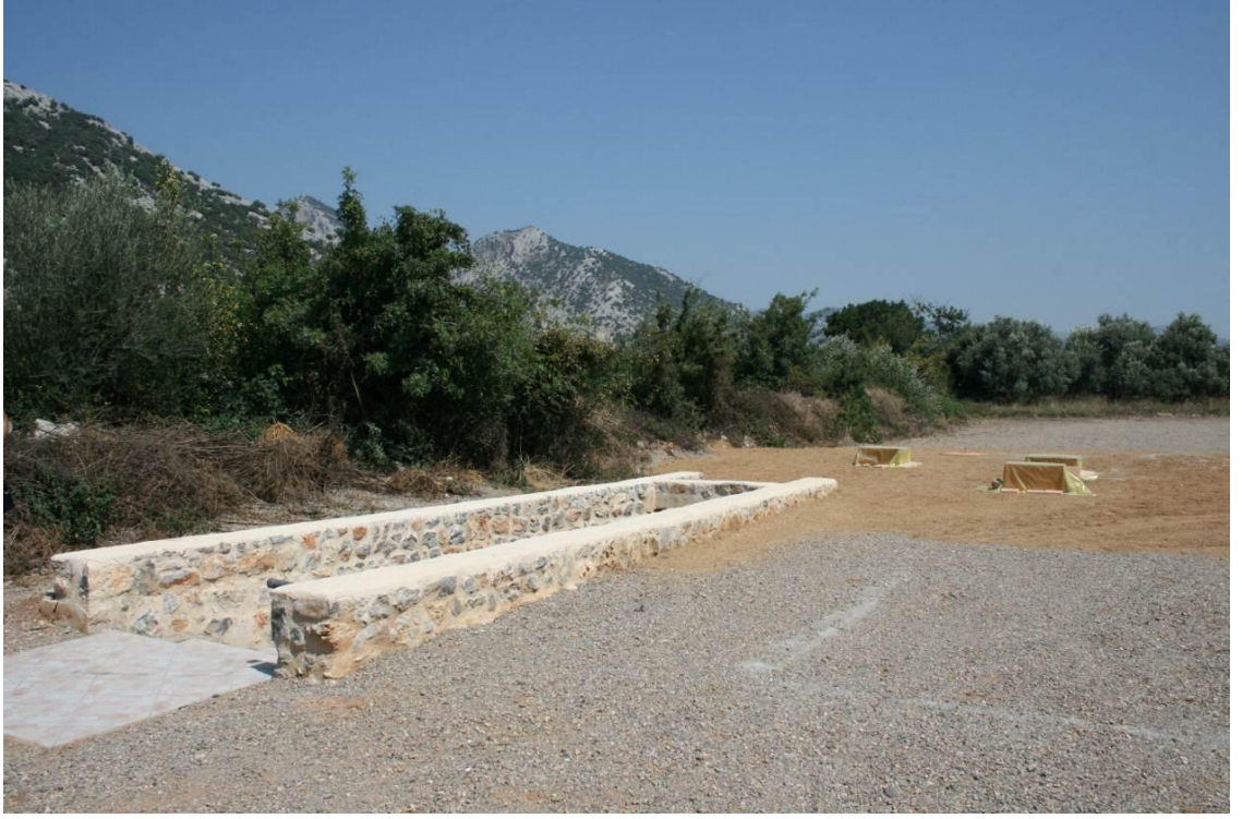
Levha:67 Kırkgöz Hanın bahçesinde güney batı köşeye yapılan tuvalet (2011)
