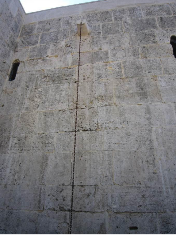
Levha:90 Susuz Handa tamamlanan çörtlenler ve çörtlenlere yapılan zincirler (2011)
