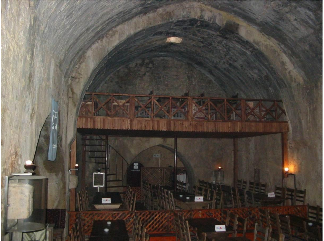
Levha:156 Alara Han batı galerisinde ahşaptan çıkmalarla oluşturulan asma kat görünümlü oturma bölümler (2011)
