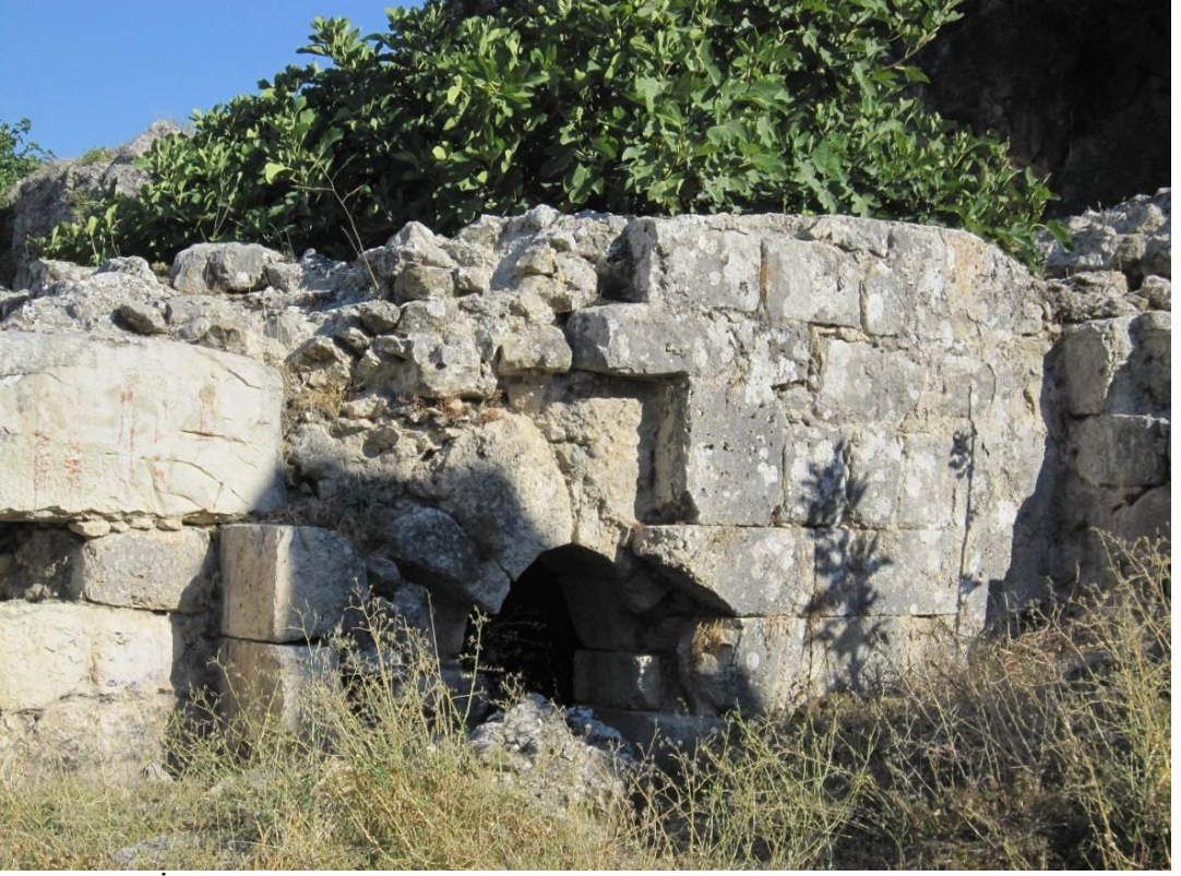
Levha:103 İncir Hanın güneydoğusundaki hamam yapısı (2011)
