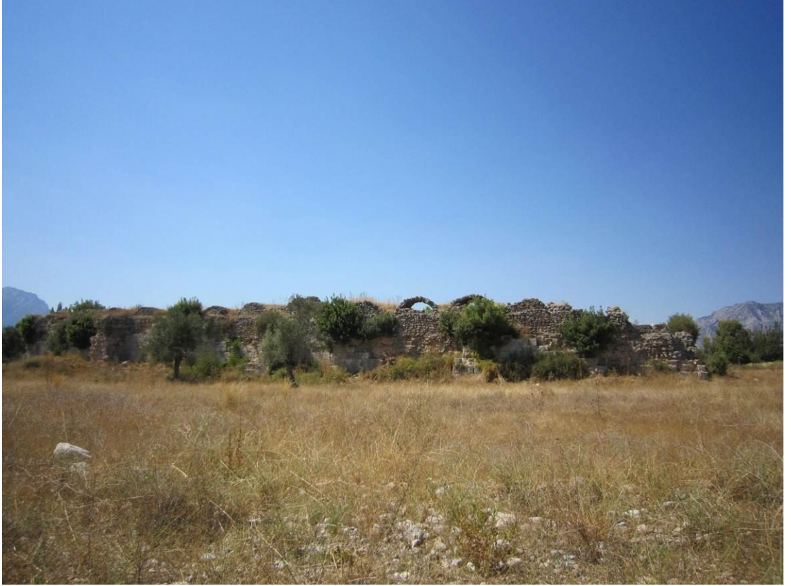
Levha:33 Emdir Han dođu cephesi (2011)
