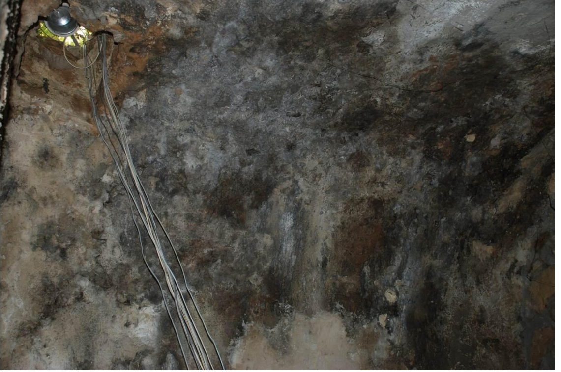
Levha:171 Alara Handa görsel kirliliğe yol açan, açıkta bırakılan elektrik kabloları (2011)
