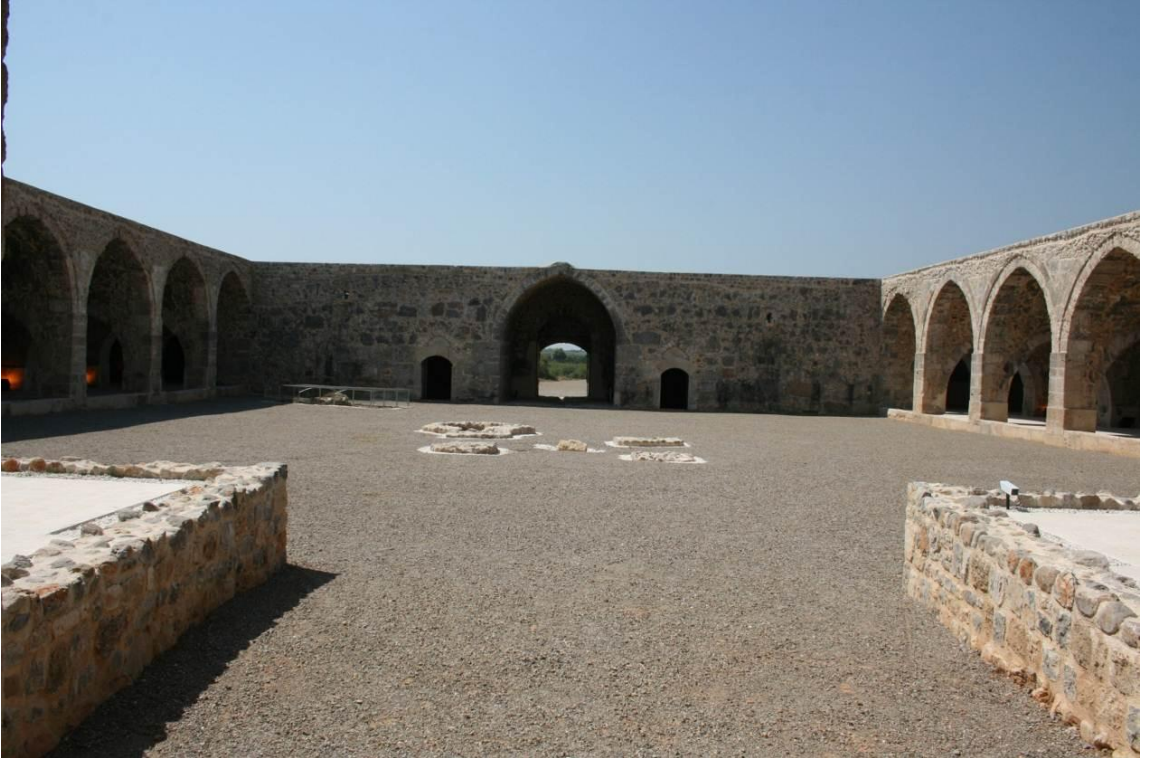
Levha:50 Kırkgöz Han giriş eyvanı yanındaki odaların cepheden görünüşü (2011)
