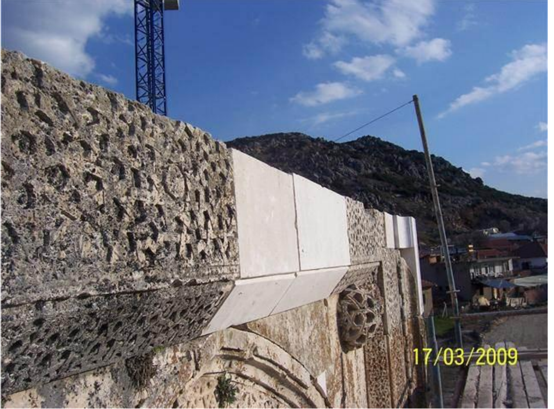
Levha:86 Susuz Han taç kapı bitişleri tamamlama çalışmaları yapılırken (2009)
