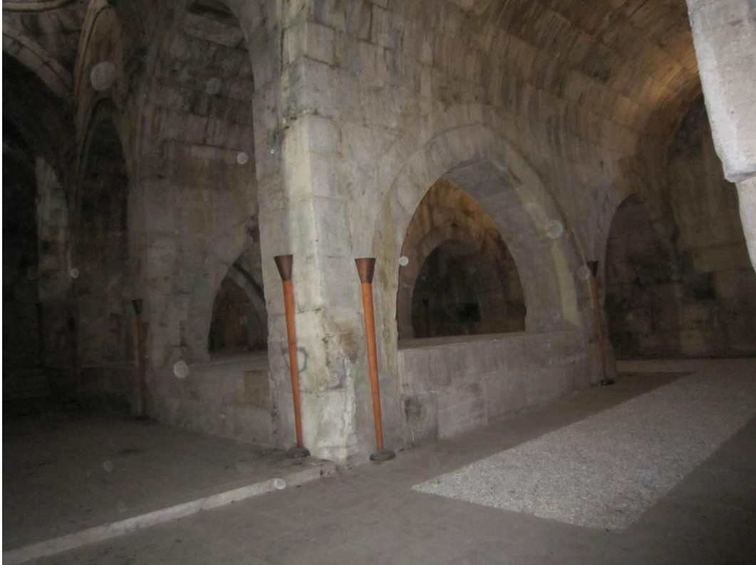
Levha:76 Susuz Han taş blok kaplanan iç mekan döşemeleri (2011)
