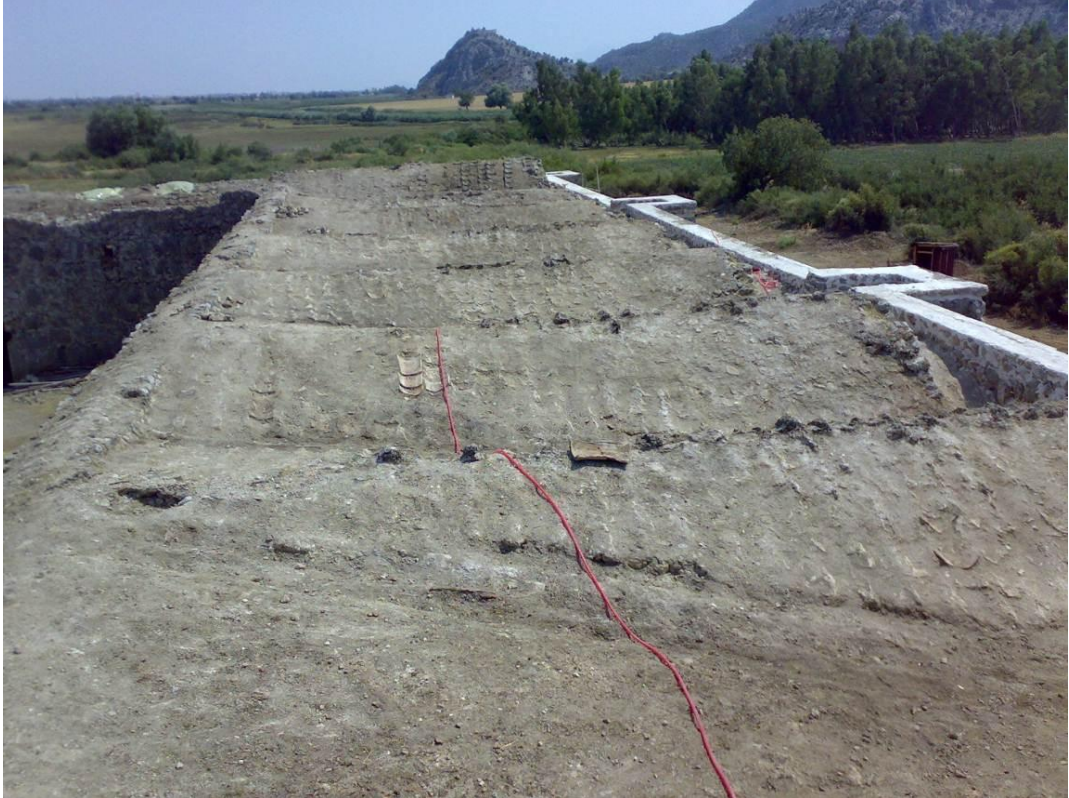
Levha:58 Kırkgöz Han üst örtüsünde onarım sırasında görülen kiremit kaplama (2006)
