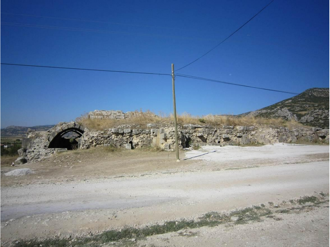
Levha:96 İncir Han dođu cephesi (2011)
