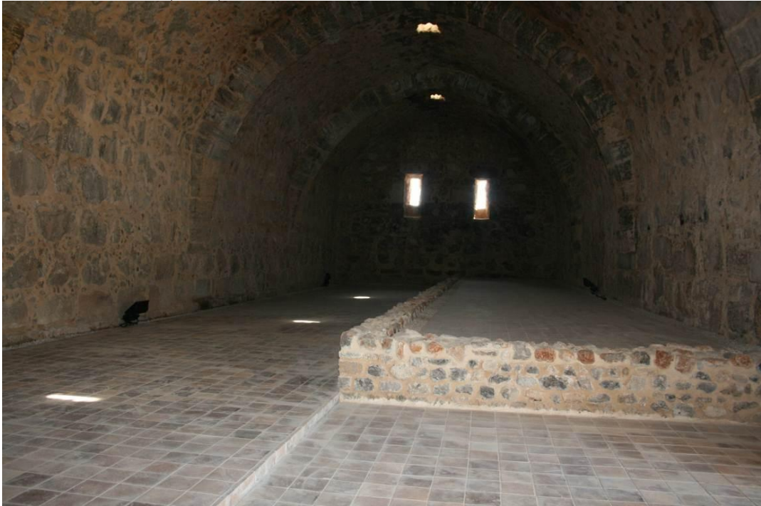
Levha:62 Kırkgöz Han kapalı bölümdeki sekilerin tamamlanan bordürleri ve imitasyon podima karo ile kaplanan zemin ( 2011)
