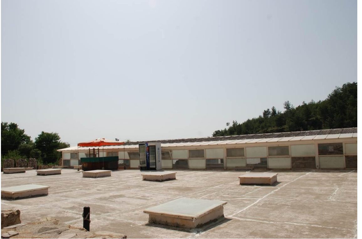
Levha:160 Alara Han projesinde cam+çelik çerçeve kapak yerleştirilmesi öngörülmüşken bugün şeffaf örtü kaplı kare formulu ışıklıklar (2011)
