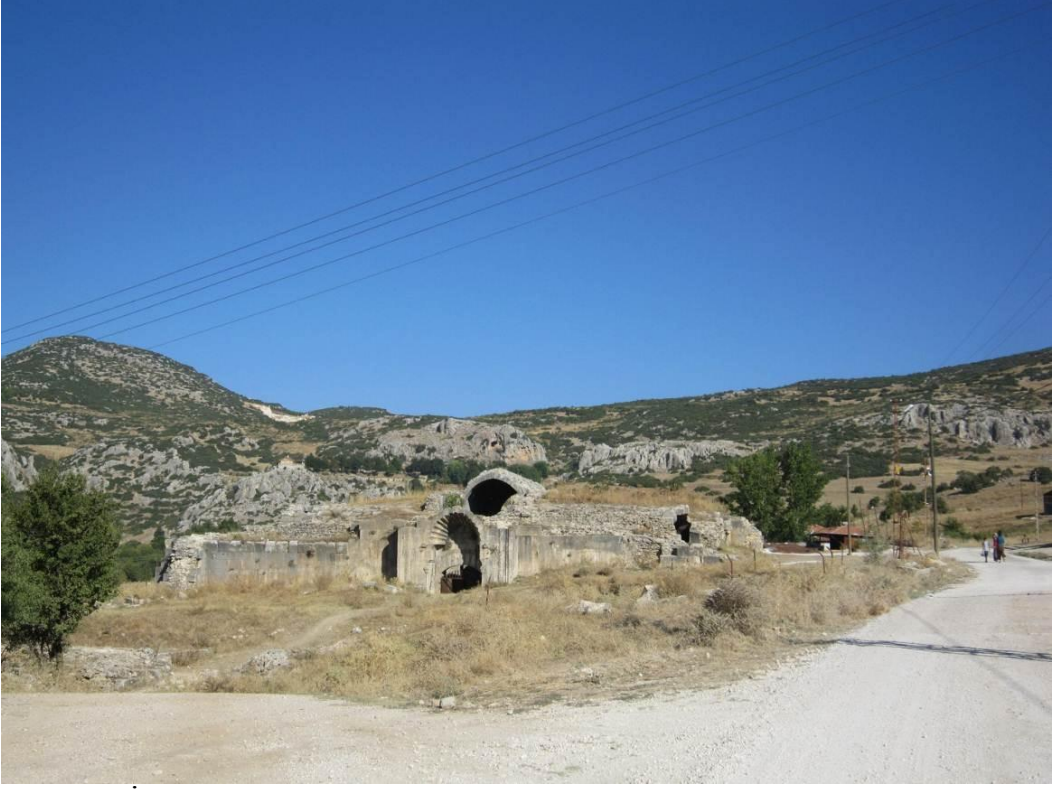
Levha:99 İncir Han güney cephesi (2011)
