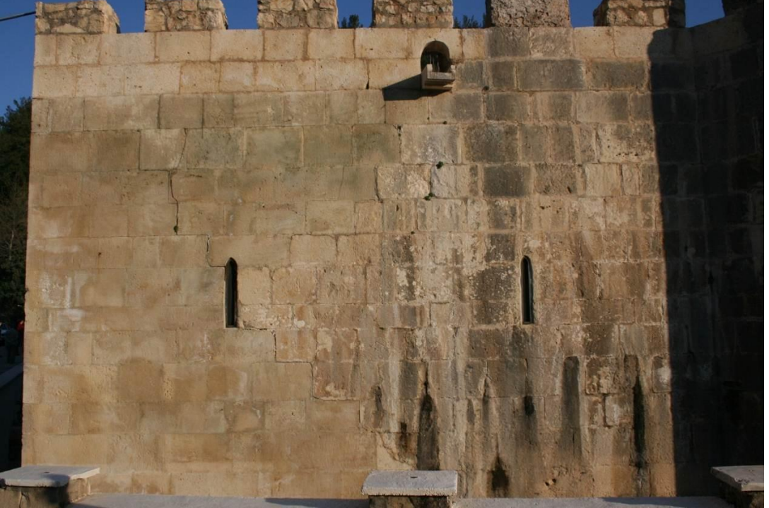
Levha:168 Alara Hanın üst örtüsünden aldığı suyun hanın dış duvarlarında oluşturduğu çatlaklar (2011)
