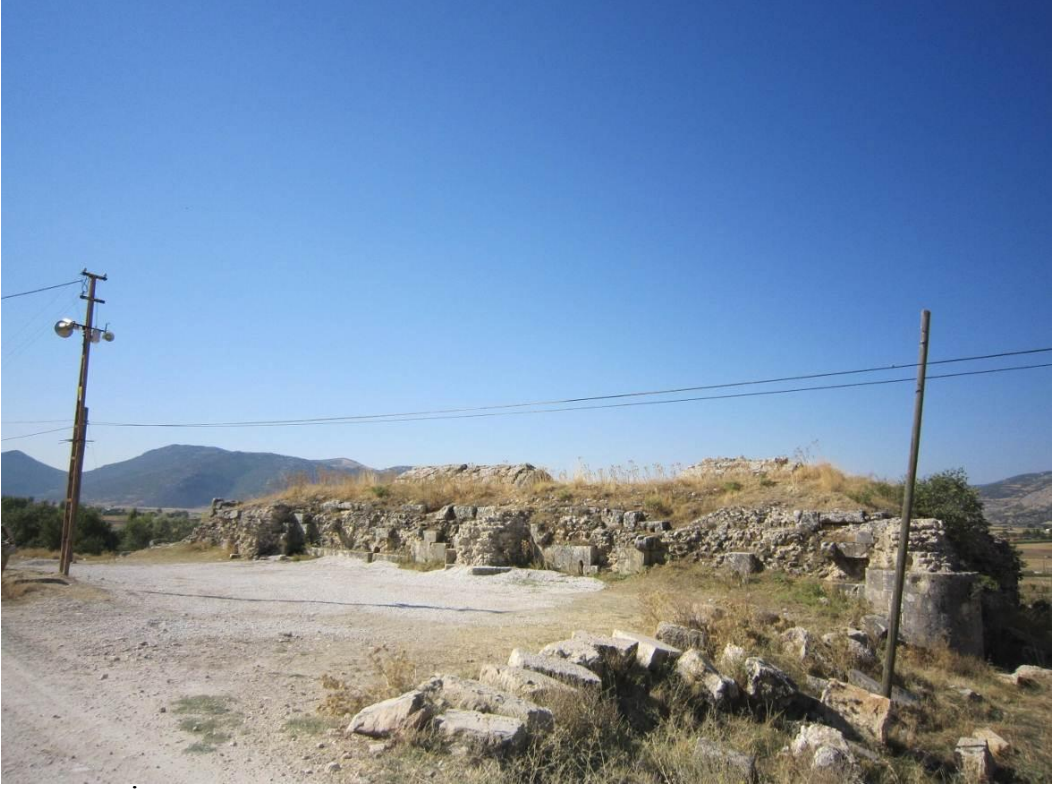
Levha:95 İncir Han dođu cephesi (2011)
