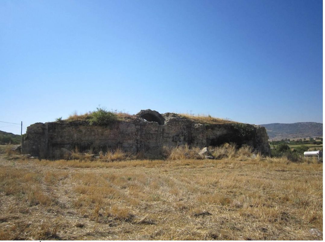
Levha:97 İncir Han kuzey cephesi (2011)
