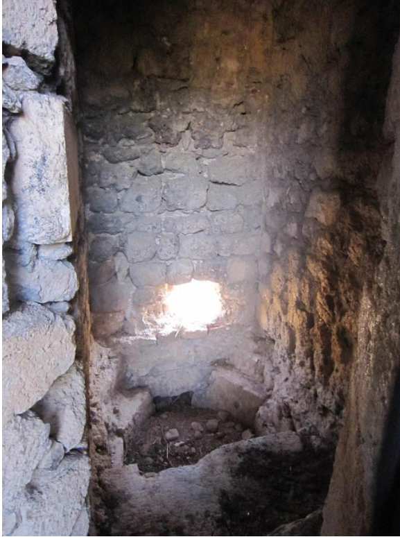
Levha:40 Emdir Hanın payanda içindeki tuvalet mekanı (2011)
