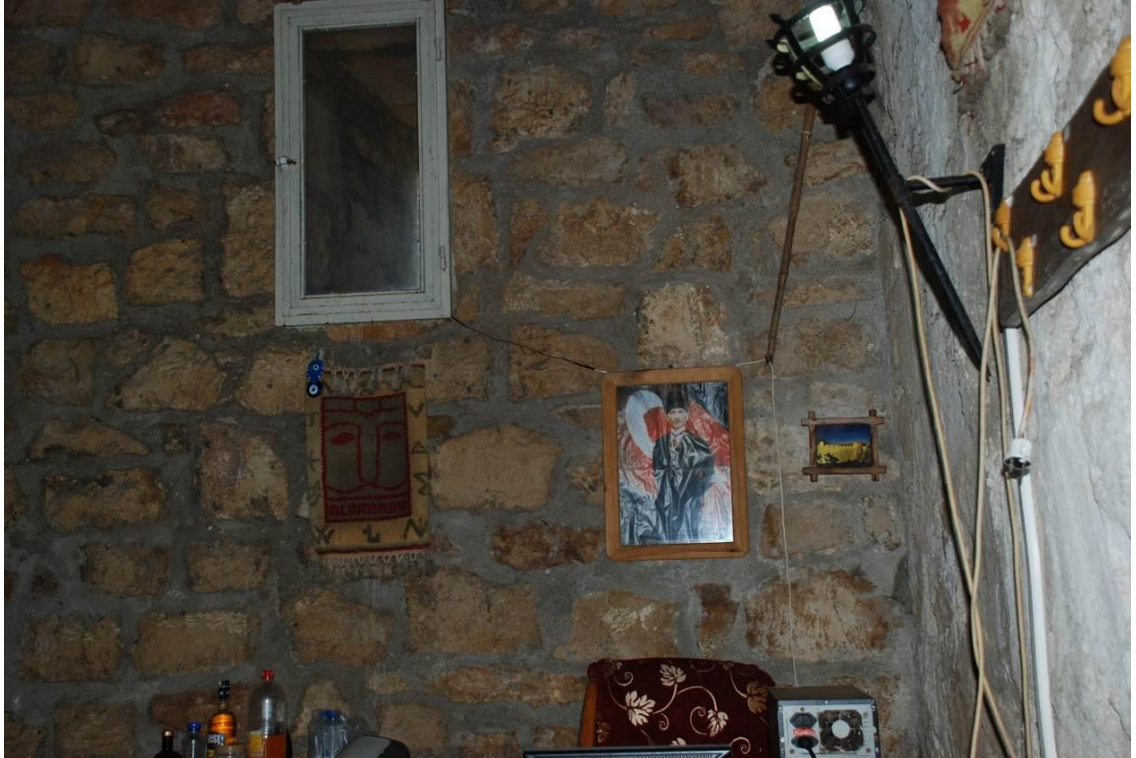
Levha:163 Alara Hanın mazgal pencerelerine yapılan açılır kanatlı pencere doğramaları (2011)
