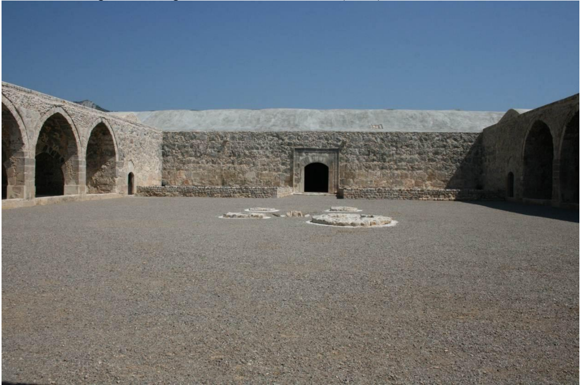
Levha:54 Kırkgöz Han kuzeyindeki kapalı bölüm (2011)
