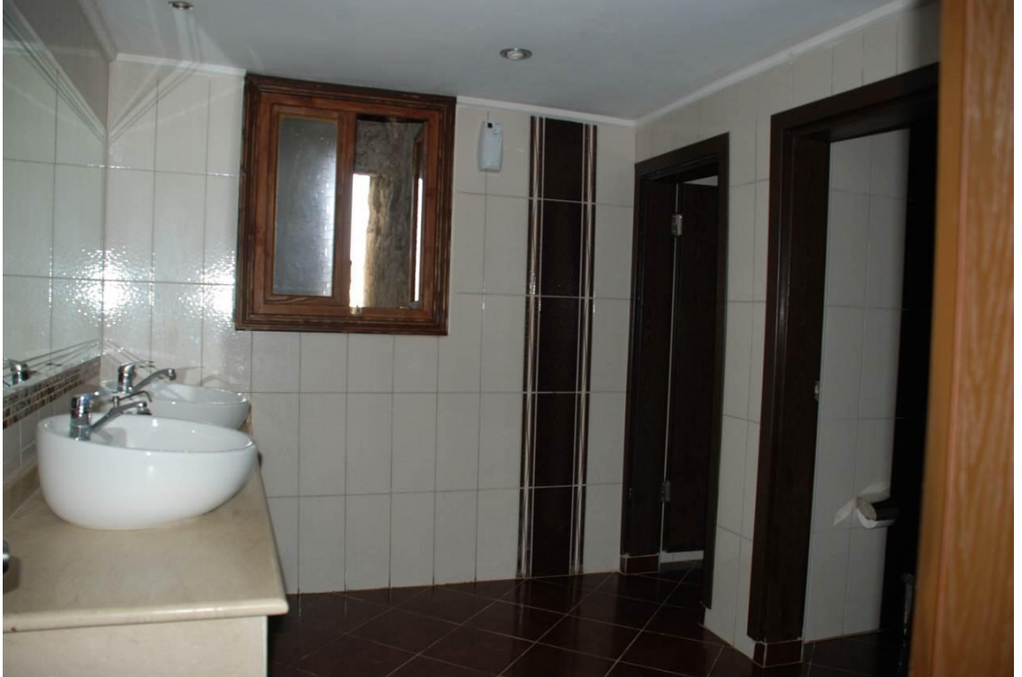
Levha:126 Şarapsa Hanın banyo bölümünü havalandırmak için hanın mazgal pencerelerine denk getirilerek tuğla duvarda açılan pencere boşlukları (2011)
