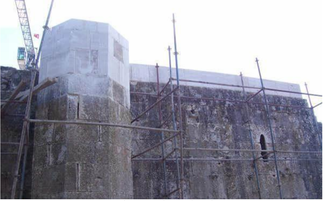
Levha:85 Susuz Han beden duvarları tamamlama çalışmaları (2009)
