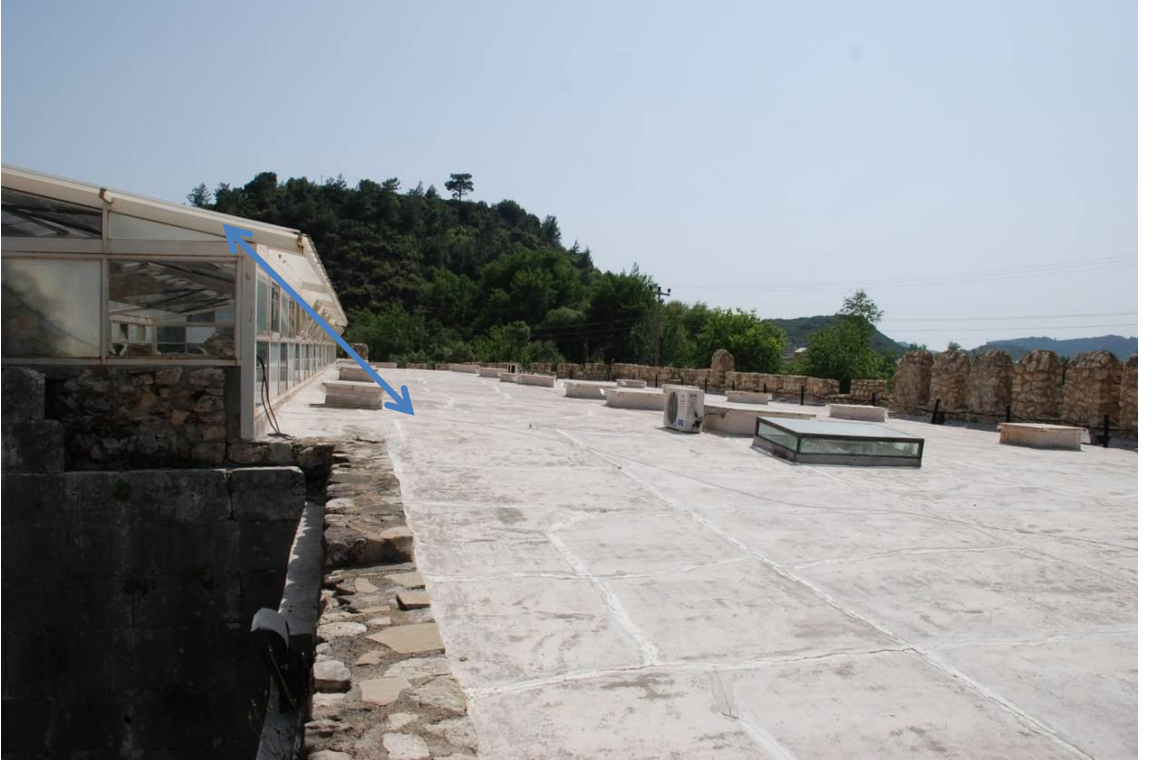
Levha:158 Alara Han polikarbonat + metal malzemeyle örtülmüş ota kısım üst örtüsü (2011)
