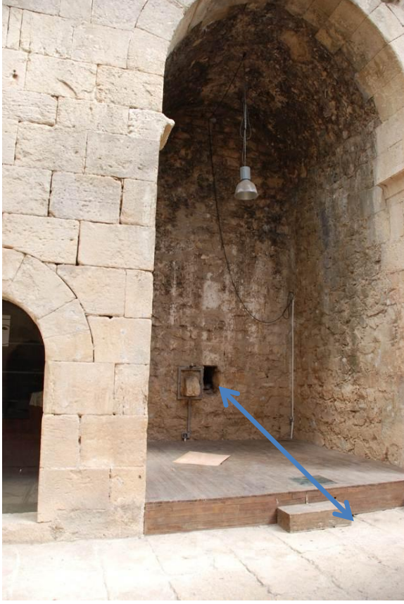
Levha:149 Alara Han orta bölüm eyvanının ahıra açılan dikdörtgen penceresi (2011)
