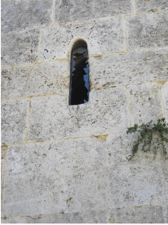
Levha:91 Susuz Hanın restorasyonu sırasında kapatılmış mazgal pencerelerinin kırılan camları (2011)
