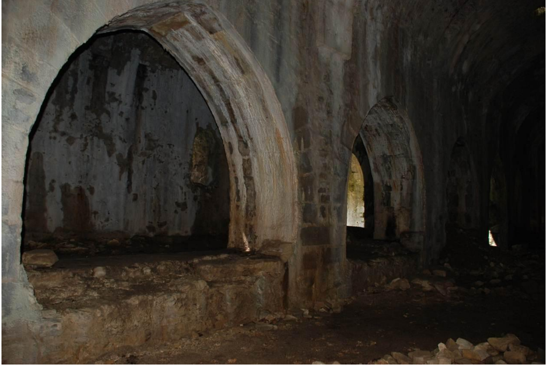
Levha:27 Kargı Hanın iki enlemesine beşik tonozlu barınak kısmı (2011)
