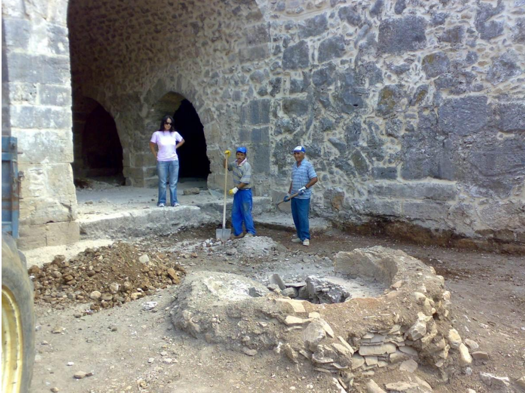
Levha:56 Kırkgöz Han avlunun güneydoğu köşesindeki tandır olduğu düşünülen çukur (2006)
