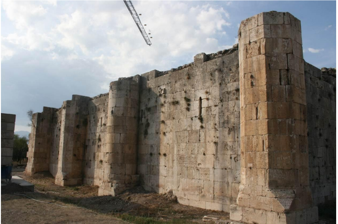
Levha:70 Susuz Han güney cephe (2008)
