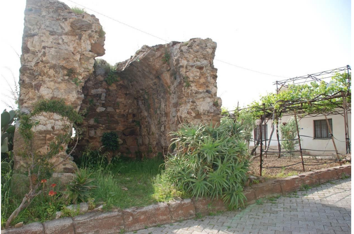
Levha:118 Şarapsa Hanın batısındaki kalıntı (2011)
