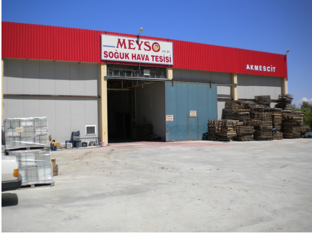
Foto 3: Termomekanik Yolla Soğutulan Soğuk Hava Depolarından Bir Görünüm (Gelendost/Isparta)
