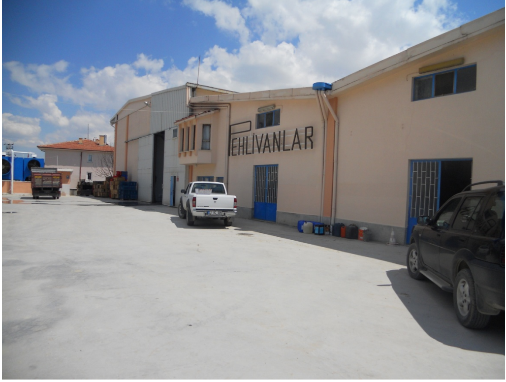
Foto 30: Pehlivanlar Soğuk Hava Deposu
