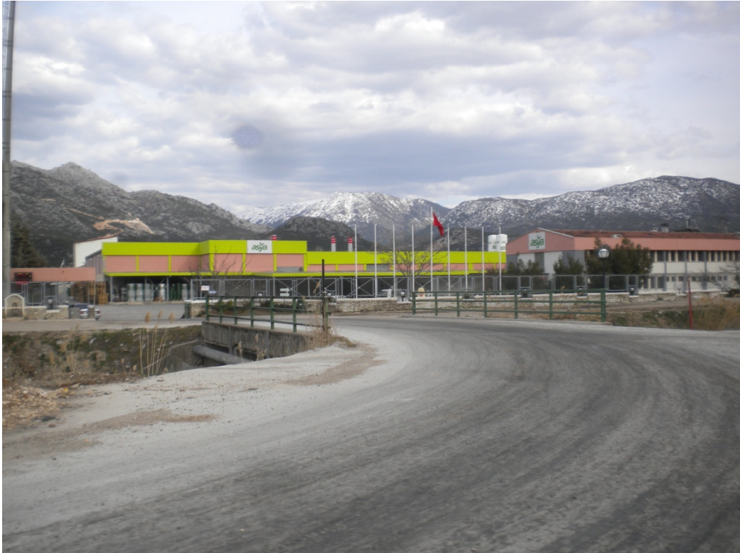
Foto 11: Eğirdir'deki Meyve Suyu İşleme Tesisi
