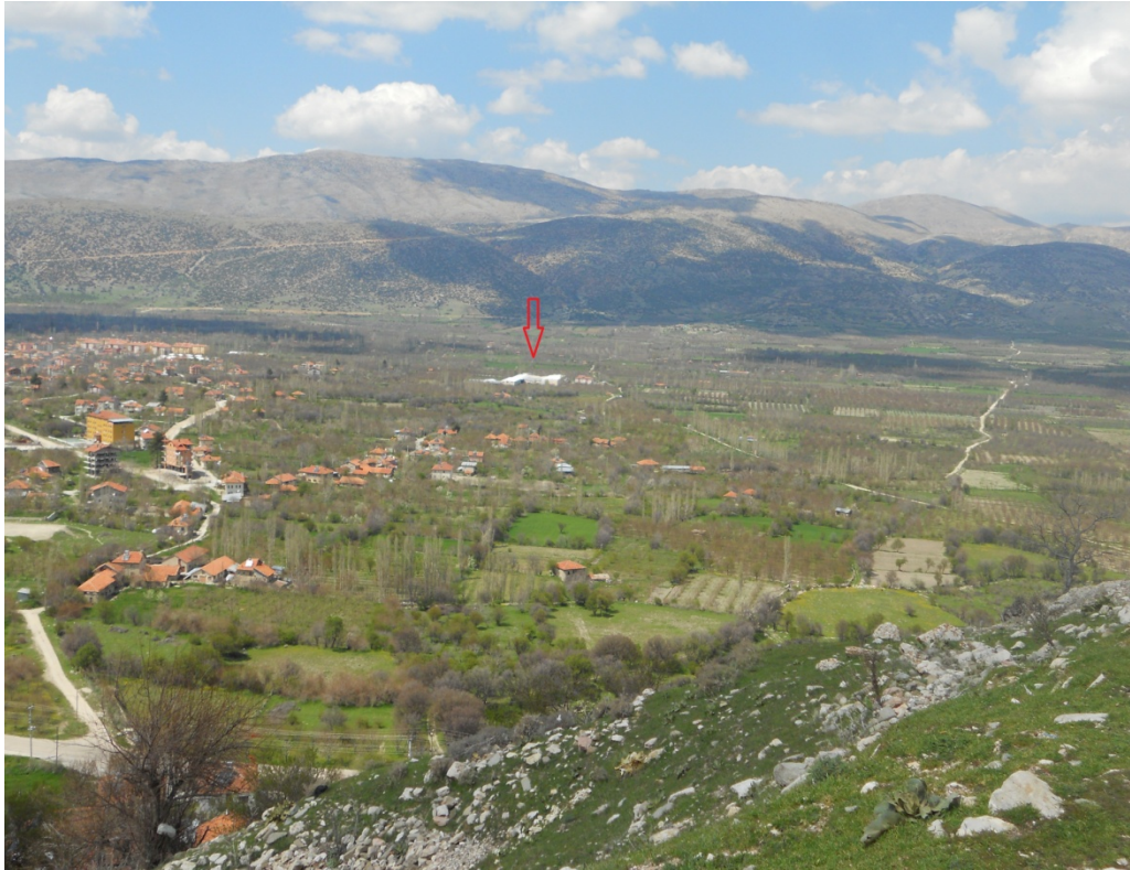
Foto 29: Uluborlu'daki Tarım Sahasında İnşa Edilen Pehlivanlar Soğuk Hava Deposu
