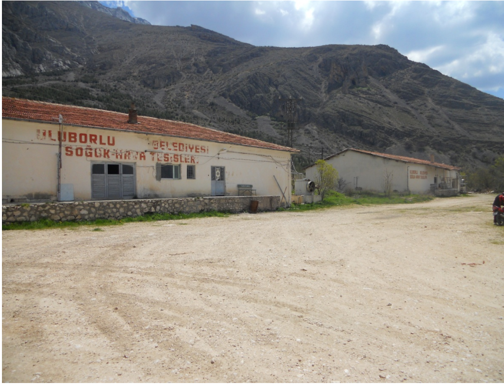
Foto 13: Faaliyetini Durduran Uluborlu Belediyesi Soğuk Hava Deposu
