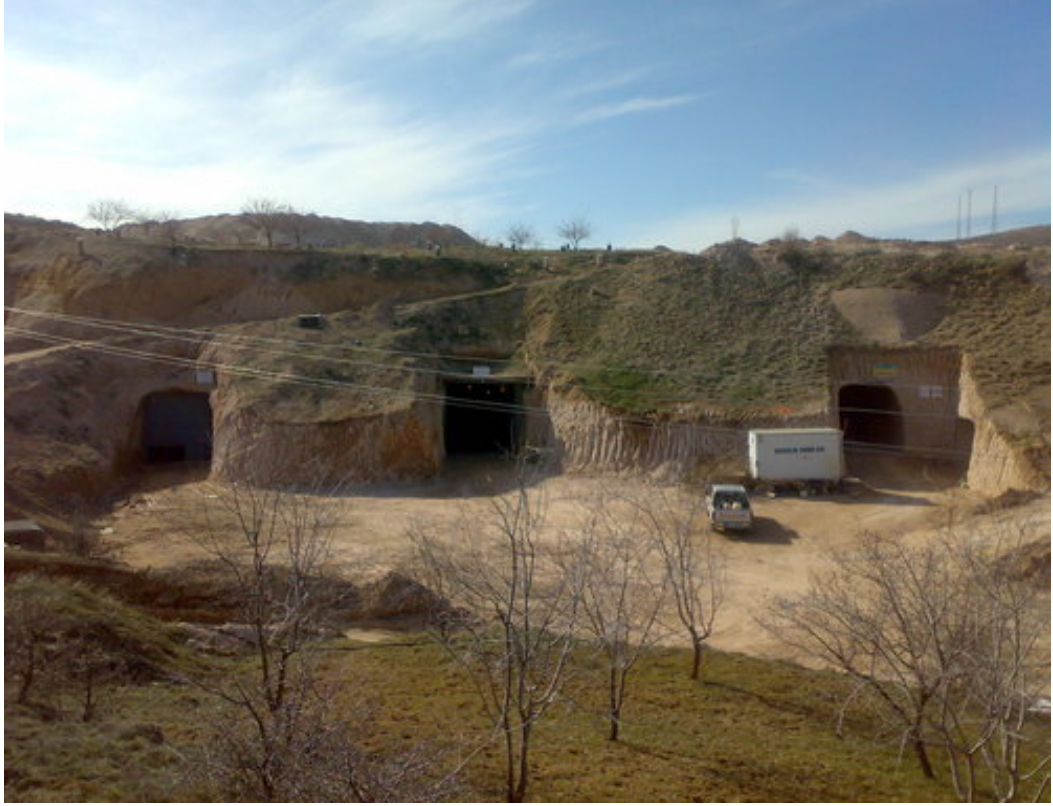
Foto 1: Taşkınlar Patates ve Narenciye Depolama Tesisi (Kavak/Nevşehir)
