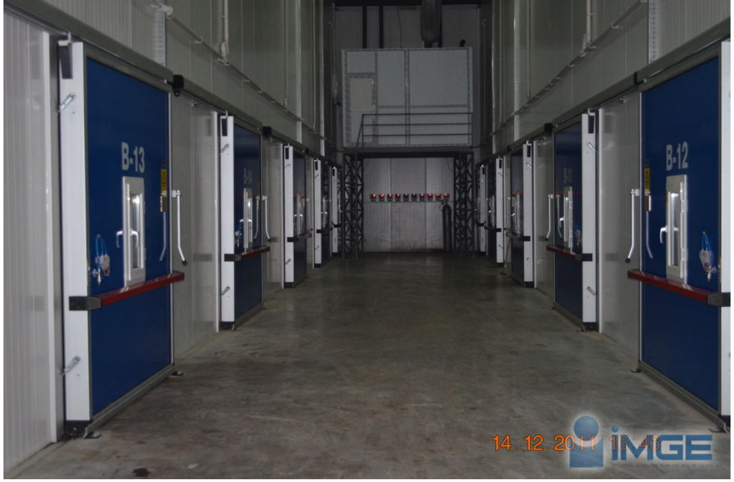
Foto 5: Atmosfer Kontrollü Soğuk Hava Deposundaki Odalardan Bir Görünüm
