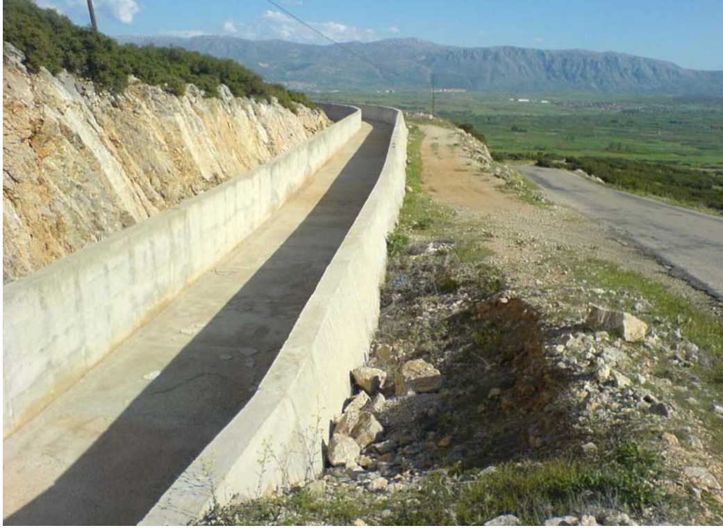
Foto 24: Gelendost Ovası'ndaki Meyve Alanlarının Sulanması Amacıyla İnşa Edilen ve Henüz Faaliyete Geçmeyen Sulama Kanalı
