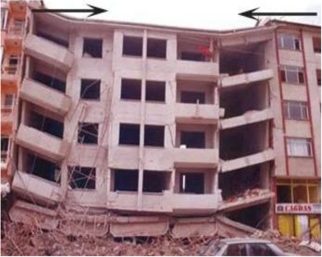
Şekil 1.3. Bitişik nizamda ortada kalan bina ( https://megainsaatvemimarlik.wordpress.com/tag/cekiceme-etkisi/ )
