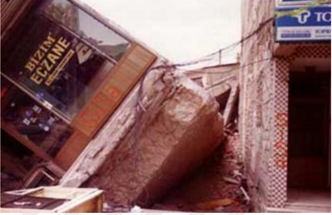
Şekil 1.7. Bodrum olmayan yapılarda çekileme ( http://www.insaatmag.com/cekileme-etkisi-nedir/ )
