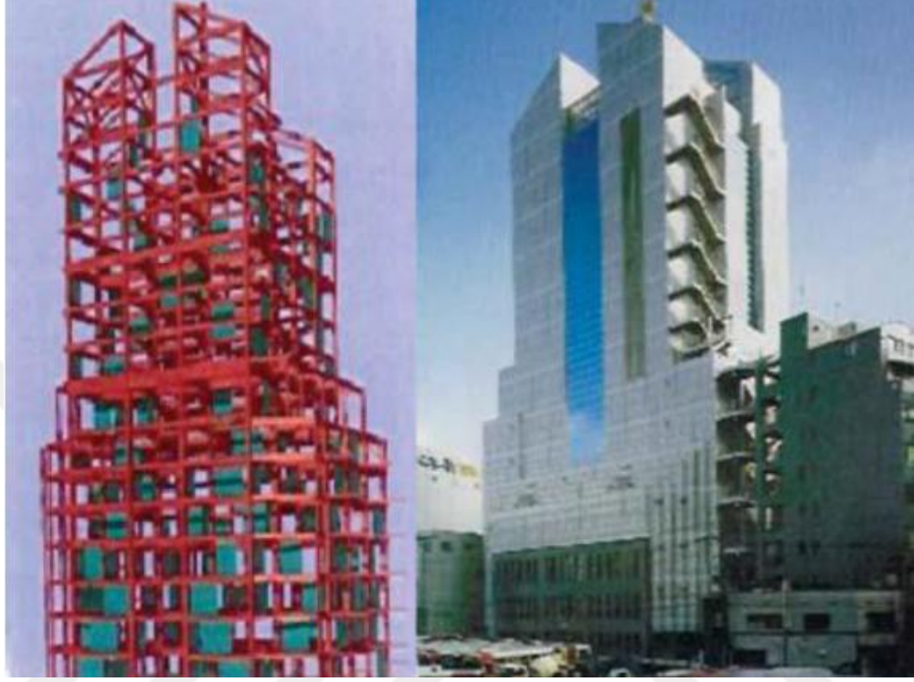
Şekil 2.3. SUT binası, Shizuoka, 1993 (Aldemir and Aydın, 2005)
