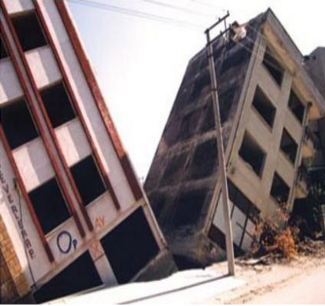
Şekil 1.6. Bodrum olmayan yapılarda çekiçleme ( http://www.insaatmag.com/cekicleme-etkisi-nedir/ )
