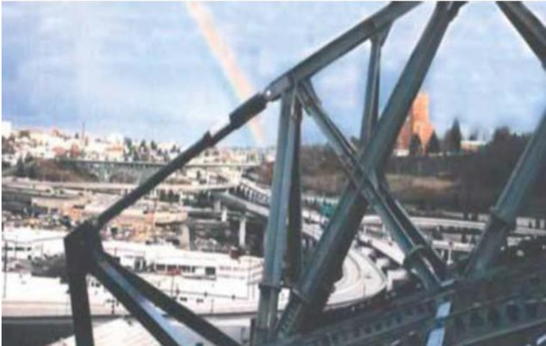
Şekil 2.4. Çelik kafes sistemde viskoz sönümleyici (Aldemir and Aydın, 2005)
