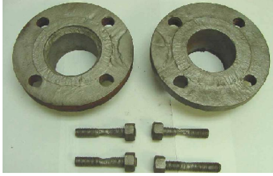
Fotoğraf 2.28. Çeşitli cephelerde çatlak korozyonuna mükemmel bir örnek, flanş yüzleri arasında kapsamlı korozyon ve civata korozyonu görünümü
