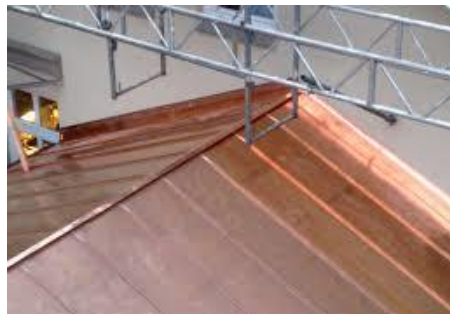
Fotoğraf 2.5. Çatı kaplama
