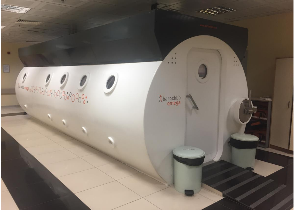
Şekil 2.2. Gülhane Tıp Fakültesi Sualtı Hekimliği ve Hiperbarik Tıp Anabilim Dalı'nda bulunan çok kişilik basınç odası
