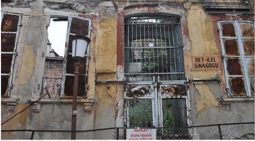
Fotoğraf 16: Bet Hillel Havrası Restorasyon Öncesi Durumu
