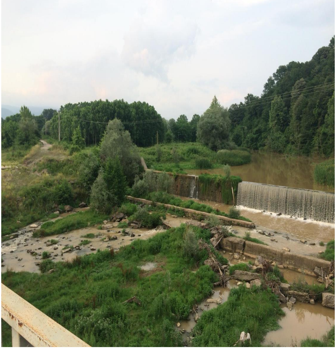
Ek- 8 Sakarya akallık Ky Barajı.
