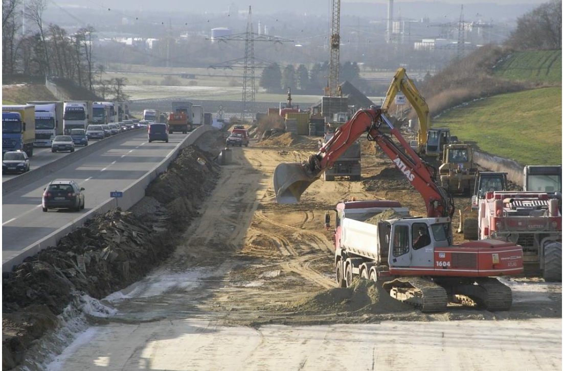
Fotoğraf 2: Almanya A8 Otoyolu Yapım Çalışmaları
