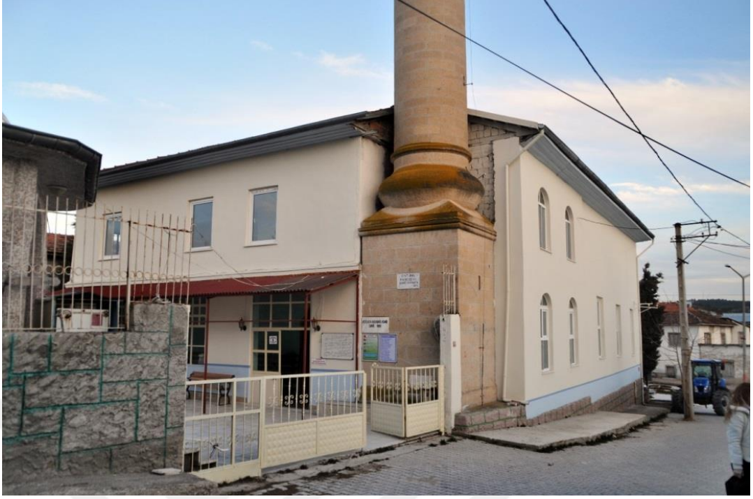
Fotoğraf 73. Kozluca Kasabası Aşağı Cami Kuzeybatıdan Görünüm
