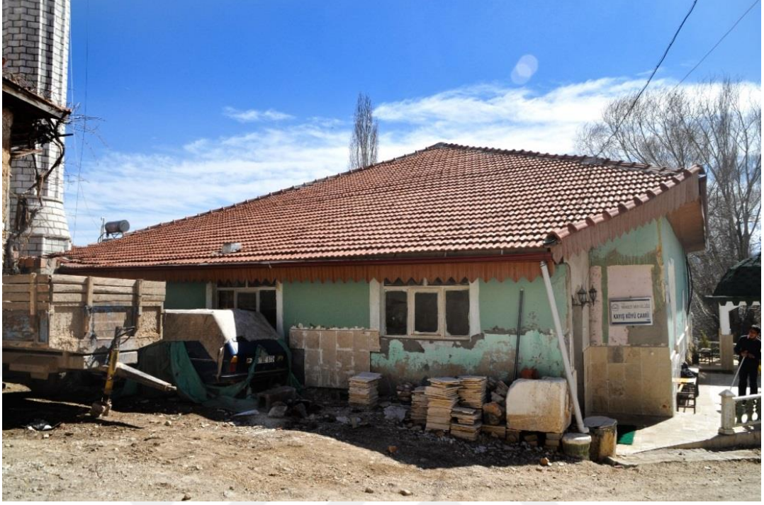
Fotoğraf 1. Kayış Köyü Cami Kuzey Cephe
