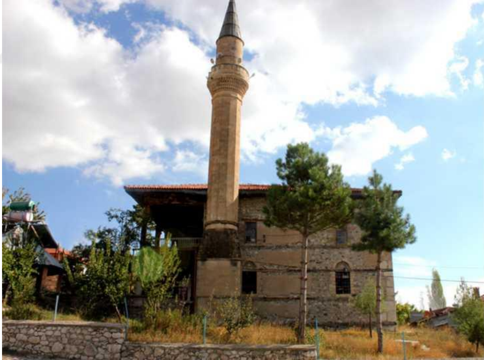
Fotoğraf 174. Dengere Köyü Cami Kuzey Cephe (S. Eroğlu'ndan)
