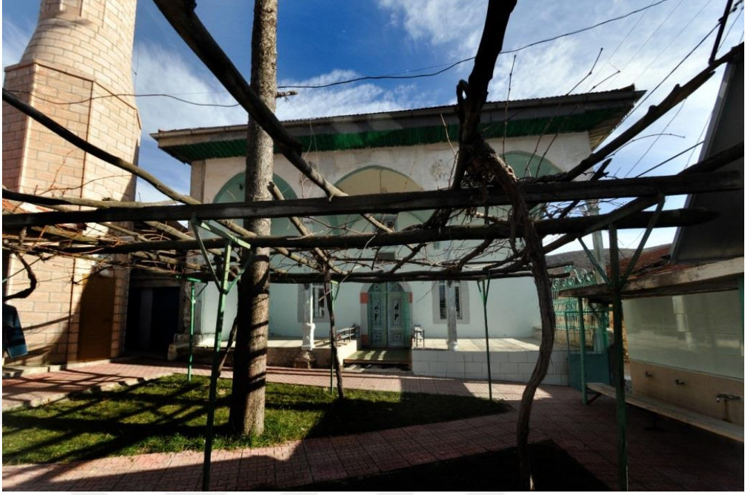
Fotoğraf 41. Günalan Köyü Lengüme Cami Kuzey Cephe
