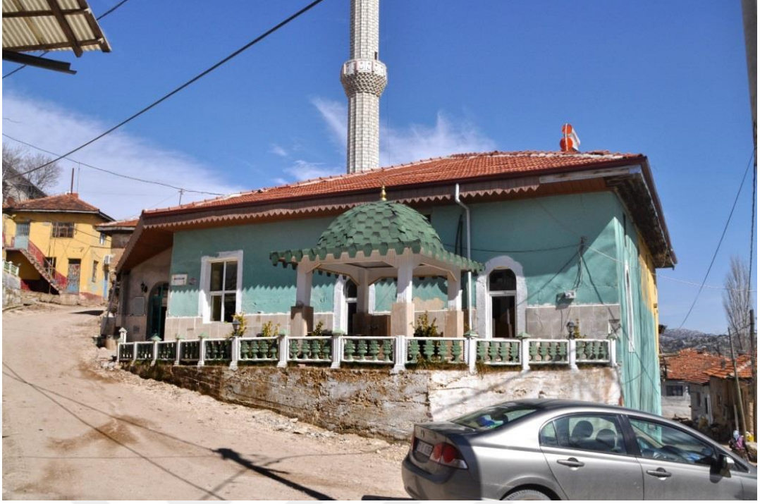
Fotoğraf 3. Kayış Köyü Cami Batı Cepheden Görünüm
