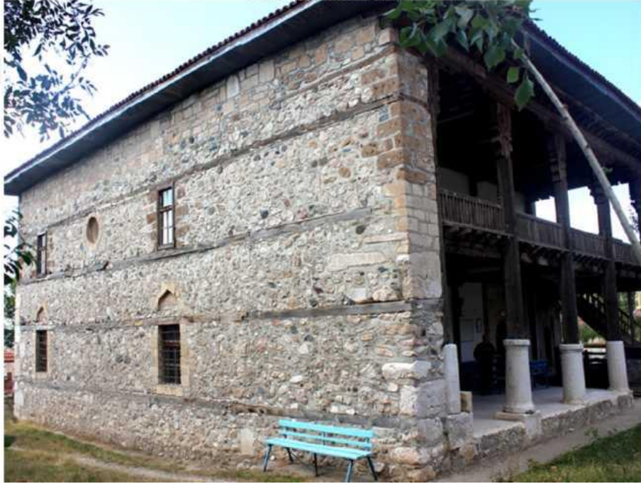
Fotoğraf 176. Dengere Köyü Cami Güneydođu Cephe (S. Erođlu'ndan)
