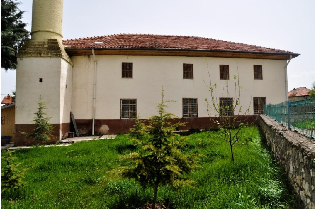
Fotoğraf 102. Kemer Köyü Merkez Yukarı Cami Batı Cephe
