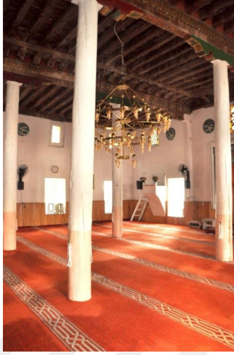
Fotoğraf 149. Harmanlı Köyü Cami Ahşap Destekler
