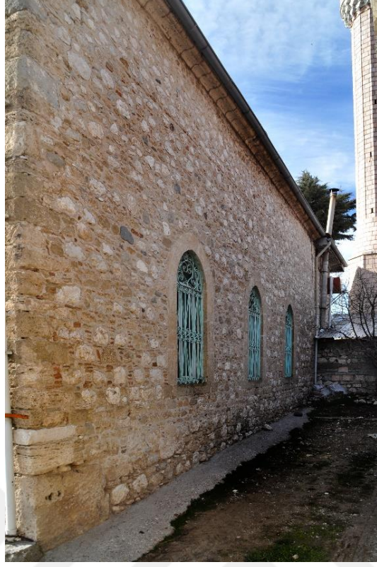
Fotoğraf 35. Günelan Köyü Lengüme Cami Doğu Cepheden Görünüm
