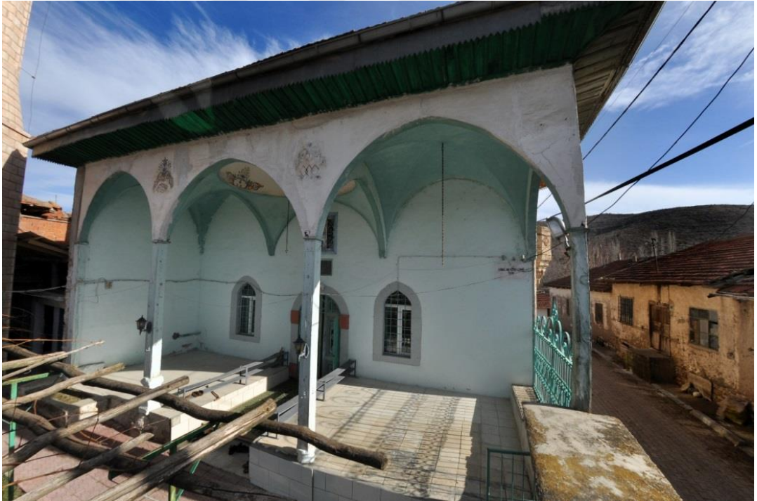
Fotoğraf 42. Günalan Köyü Lengüme Cami Kuzey Cephe
