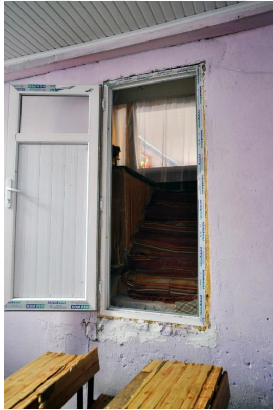
Fotoğraf 14. Kayış Köyü Cami Mahfil Kapısı
