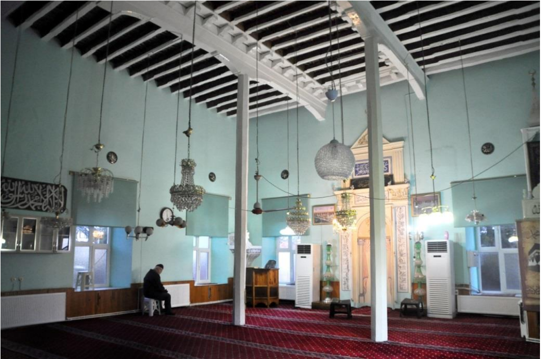
Fotoğraf 84. Kozluca Kasabası Aşağı Cami Taşıyıcı Sistem ve Ahşap Tavan
