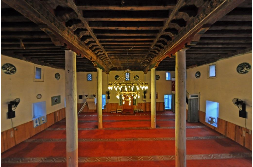
Fotoğraf 152. Harmanlı Köyü Cami Ahşap Tavan ve Taşıyıcı Sistem
