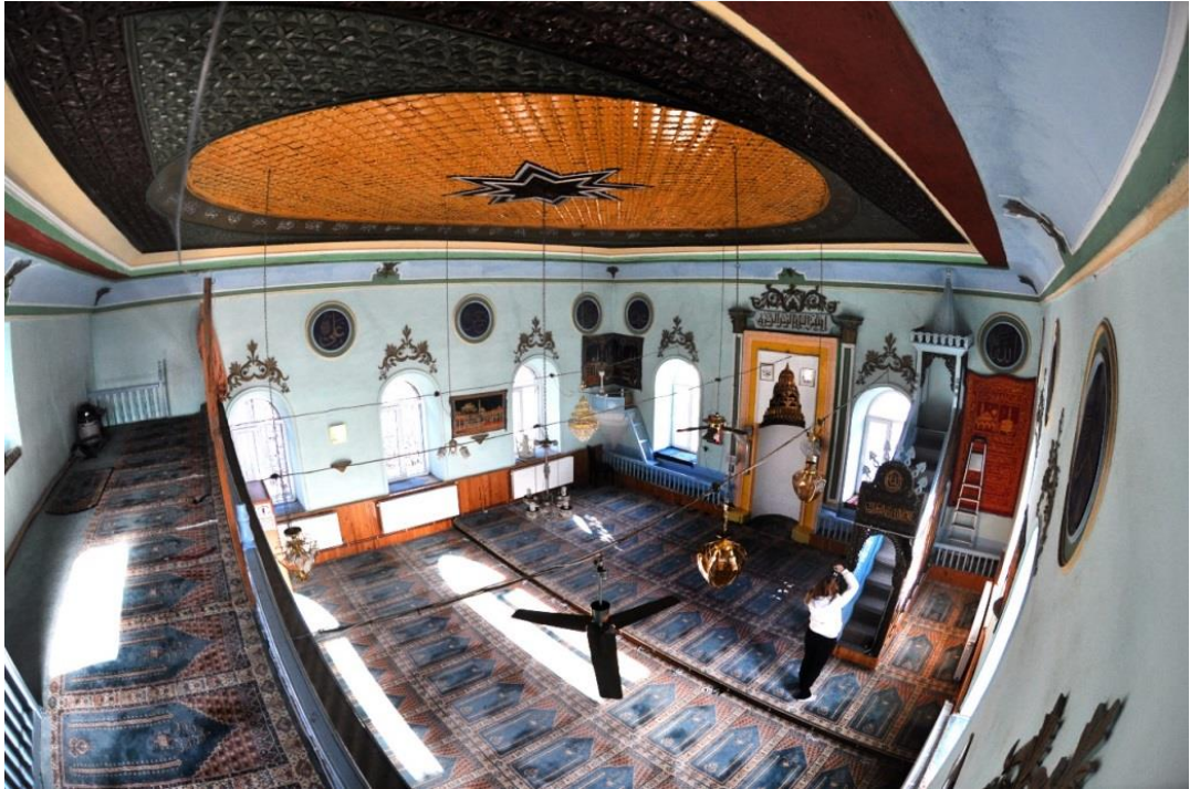
Fotoğraf 70. Günelan Köyü Lengüme Cami Harim Mekanı Genel Görünüşü
