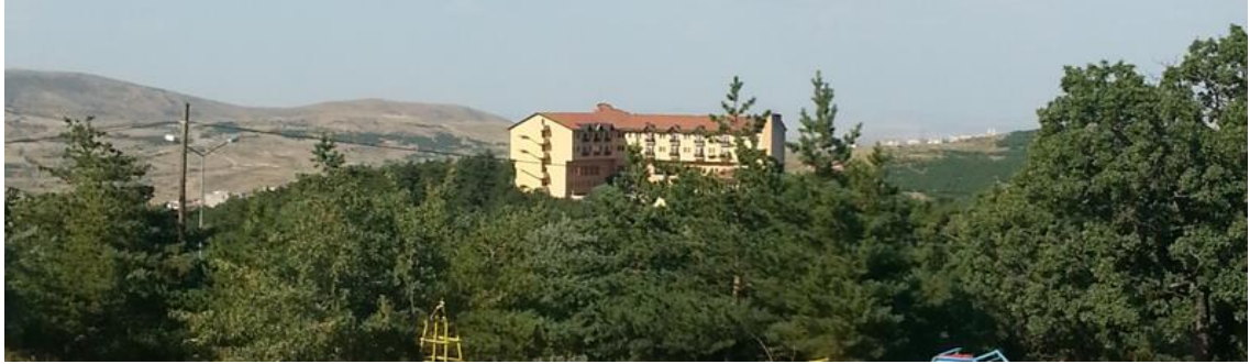
Foto 34: Milli Park İçindeki Taşdemir Tepe'ye İnşa Edilen Otel Binası
