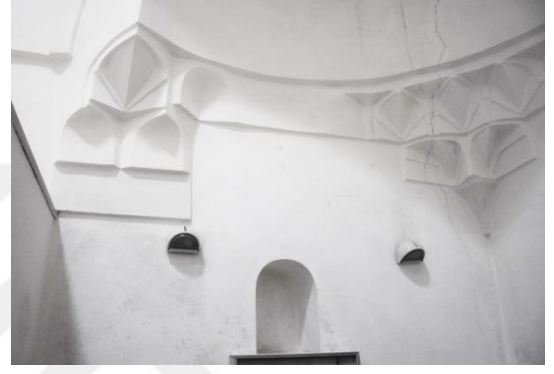
Şekil 47: Sıcak Bölümünde Kubbenin Geçiş Mukarnasının Detay Görünümü.
