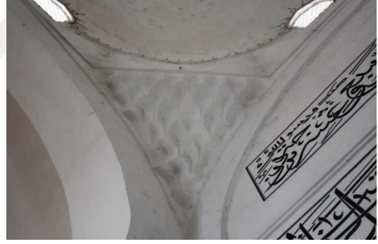
Şekil 334: Orta Kubbenin Geçiş Mukarnasının Alttan Görünümü.
