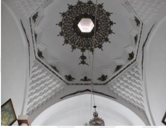
Şekil 106: Orta kubbe geçişleri Mukarnasının genel görünümü
