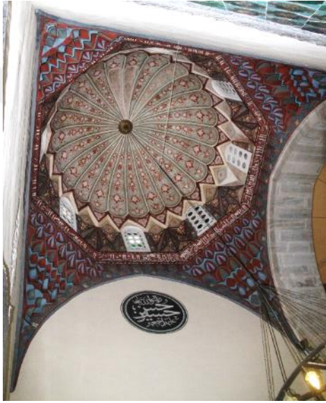
Şekil 257: Sol Eyvanın Kubbesinin Geçişleri Mukarnasının Genel Görünümü.
