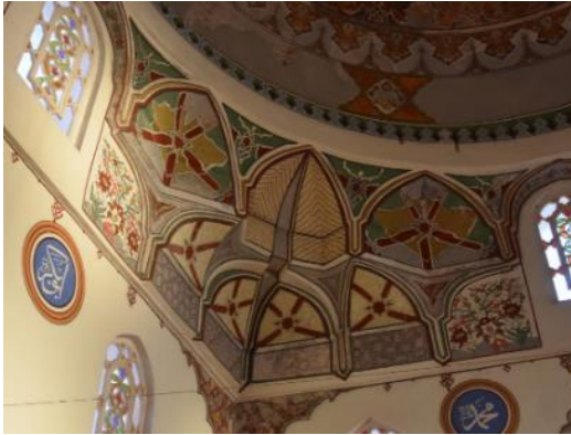
Şekil 517: Kubbe Geçişleri Mukarnasının Genel Görünümü.
