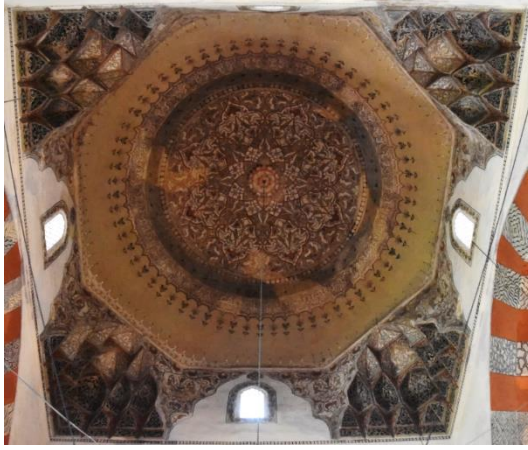
Şekil 215: Orta kubbe geçişi Mukarnasının genel Görünümü.
