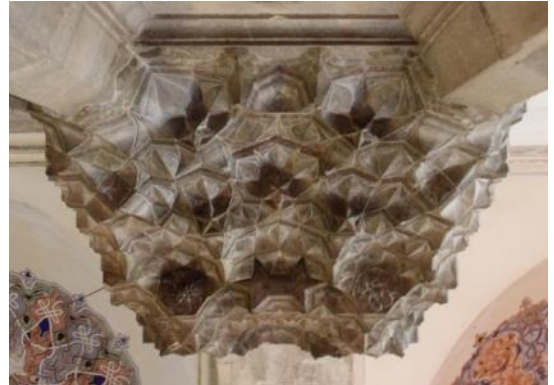
Şekil 158: Mihrap Kubbesinin Kemer Sağ Geçiş Mukarnasının Altın Görünümü.
