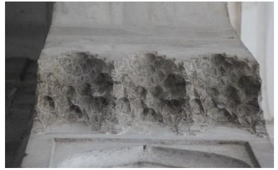
Şekil 174: Taçkapı Kemer Sağ Geçişi Mukarnasının Alttan Görünümü.
