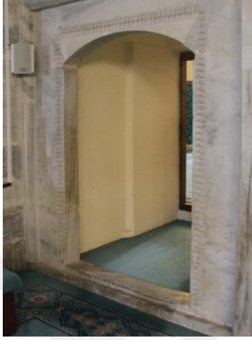
Şekil 246: Sağ Yan Odanın Kapısının Pervazi Mukarnasının Görünümü.
