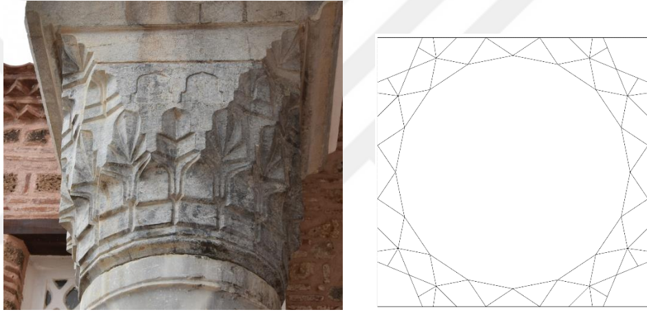
Şekil 578: İznik Nilüfer Hâtun İmâreti'nin Rivakta bir Sütunun Mukarnaslı Başlığı, Solda Çizimi.
