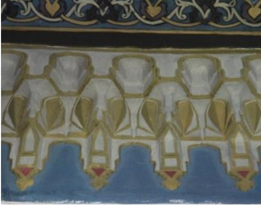
Şekil 583: Bursa Yeşil Cami'nin Taçkapısının Arkasındaki Mukarnaslı Tavan Geçışı, Solda Çizimi.
