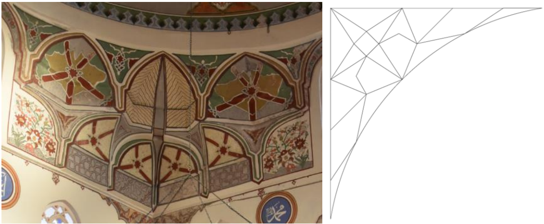
Şekil 566: Edirne Kuşçu Doğan Camii'nin kubbesinin Mukarnaslı Tromp Geçişi, Solda Çizimi.
