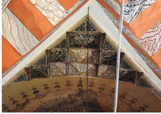
Şekil 217: Orta kubbe geçişi Mukarnasının Alttan Görünümü.
