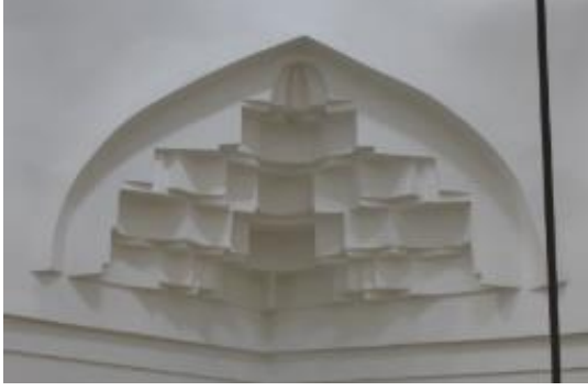
Şekil 313: Cemekeanın Kubbesinin Tromp Geçiş Mukarnasının Genel Görünümü.
