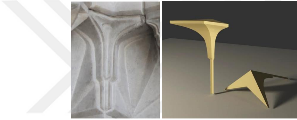
Şekil 611: Soldaki Büyük İki Ayaklı Kademeli Ara Eleman ve Sağdaki Bursa Yeşil Camii'nin Taçkapısının Mihrabiyesinde Örneği.
