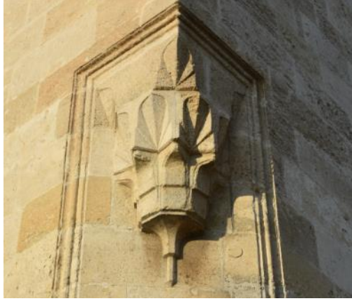
Şekil 499: Dış Duvarın Köşesi Mukarnasının Genel Görünümü.
