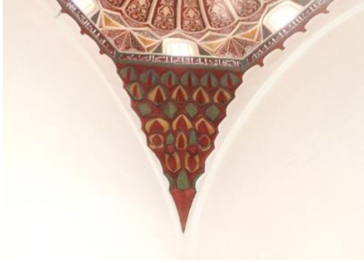
Şekil 255: Sağ Eyvanın Kubbesinin Geçiş Mukarnasının Görünümü.
