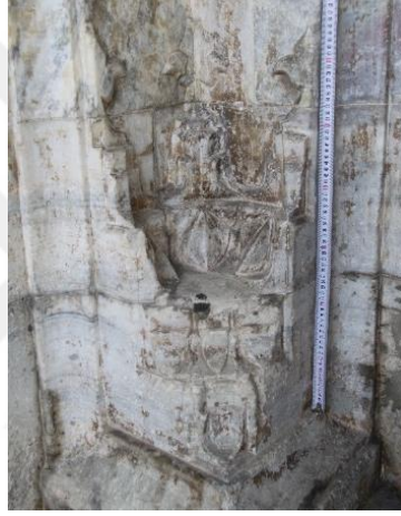
Şekil 591: Bursa Yıldırım Cami'nin Taçkapısında Mukarnaslı Köşe, Solda Çizimi.
