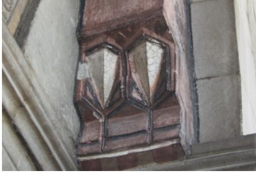
Şekil 205: Taçkapı Kemerinin Sağ Geçişi Mukarnasının Genel Görünümü.
