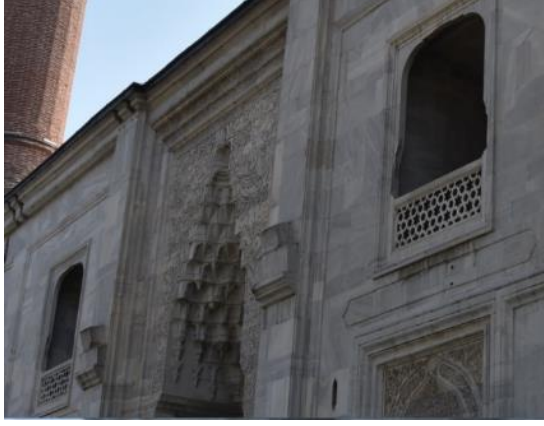
Şekil 281: Ana Cephe Balkonunun Kemer Geçişi Mukarnasının Görünümü.
