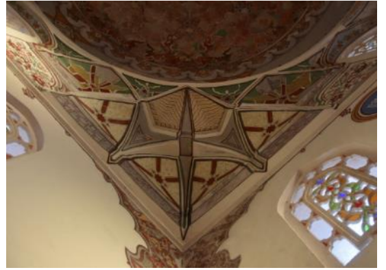
Şekil 518: Kubbe Geçişleri Mukarnasının Alttan Görünümü.
