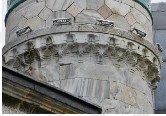
Şekil 587: İznik Yeşil Cami'nin Minaresinde Mukarnaslı Friz, Solda Çizimi.
