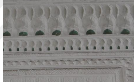
Şekil 166: Sol Yan Odanın alçı kaplamasında Mukarnasın Görünümü.
