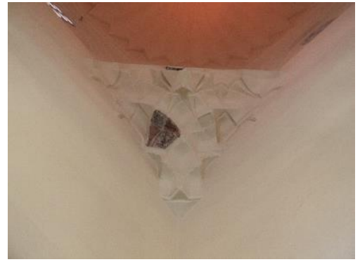
Şekil 251: Sol Yan Odanın Kubbesinin Geçiş Mukarnasının Altta Görünümü.
