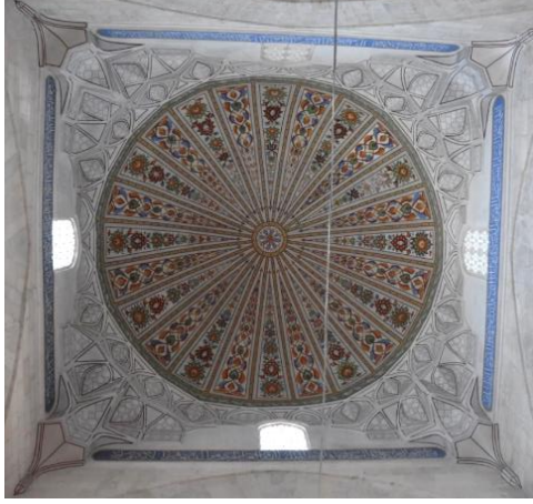
Şekil 452: Sol Ön Yan Kubbe Mukarnasının Alttan Görünümü.
