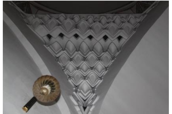
Şekil 371: Sağ Eyvanın Kubbesinin Geçiş Mukarnasının Alttan Görünümü.
