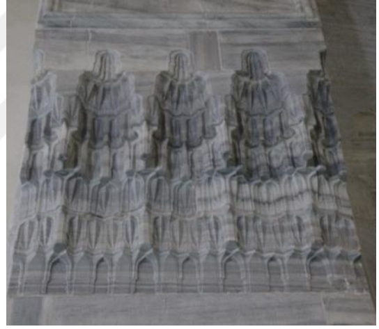
Şekil 245: Mihrap Kubbesinin Kemer Sağ Geçişleri Mukarnasının Detay Görünümü.
