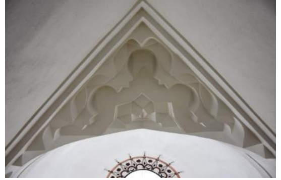
Şekil 314: Cemekeanın Kubbesinin Tromp Geçiş Mukarnasının Altın Görünümü.
