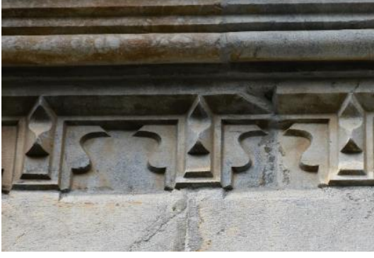
Şekil 586: İznik Yeşil Cami'nin Çatı Geçişinde Mukarnaslı Friz, Solda Çizimi.
