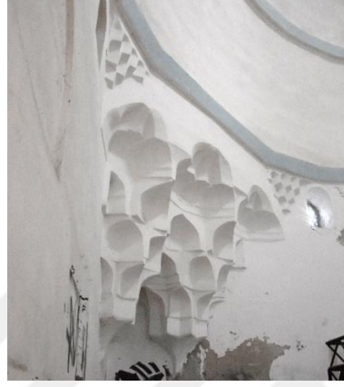
Şekil 391: Camekan Bölümünün Kubbesinin Geçişleri Mukarnasının Genel Görünümü.
