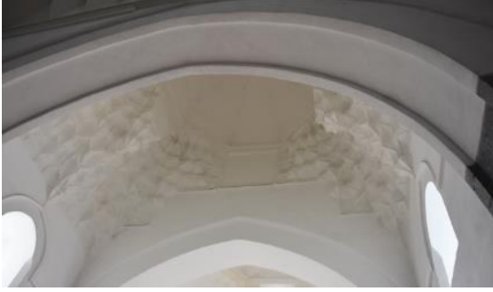
Şekil 95: Kubbe Geçişleri Mukarnasının Genel Görünümü.
