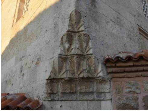
Şekil 520: Dış Duvarın Köşesi Mukarnasının Genel Görünümü.
