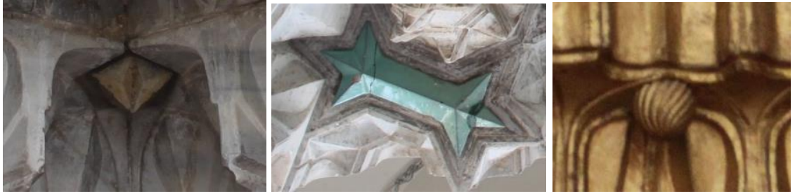
Şekil 613: Tipik Osmanlı Mukarnasın Bazı Kabartma Çeşitleri, Soldan Sırayla: Beş Köşeli Yıldız, Birleşmiş İki Yıldız Bursa Yıldırım Camii'nin Son Cemaat Mihrabında Örneği ve Burmalı Top Bursa Orhan Gazi Camii'nin Ana Mihrabında Örneği.
