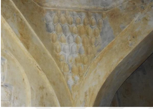
Şekil 428: Sıcaklık Bölümünün Ana Kubbesinin Geçişleri Mukarnasının Genel Görünümü.
