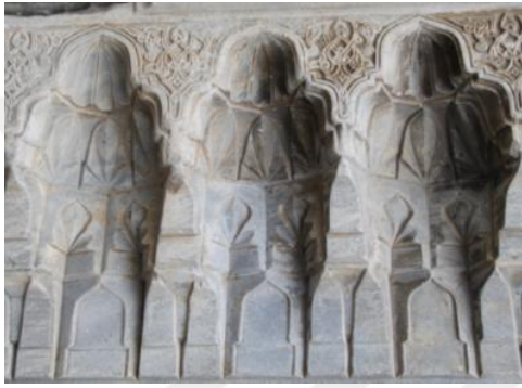
Şekil 558: İznik Yeşil Cami'nin Taçkapısının Mukarnaslı Pervazı, Solda Çizimi.
