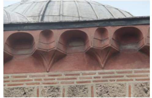
Şekil 438: Çatının Geçişleri Mukarnasının Detay Görünümü.
