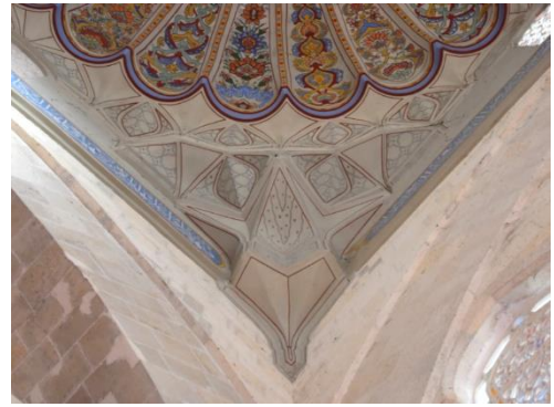
Şekil 457: Sağ Ön Yan Kubbenin Geçişleri Mukarnasının Alttan Görünümü.
