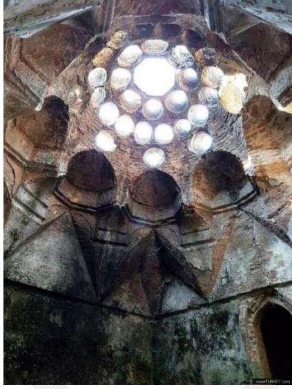
Şekil 362: Sıcaklık Kubbesinin Geçiş Mukarnasının Genel Görünümü 133 .
