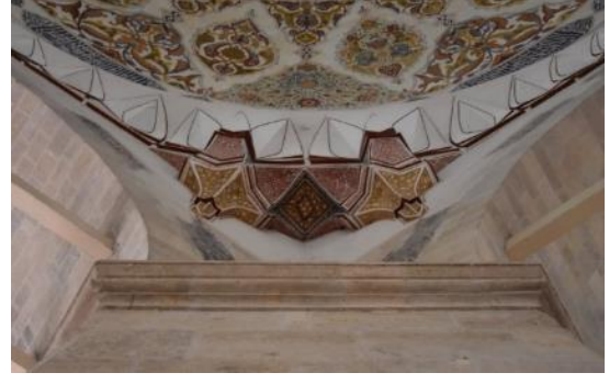
Şekil 451: Ana Kubbe Geçişlerin Mukarnasının Alttan Görünümü
