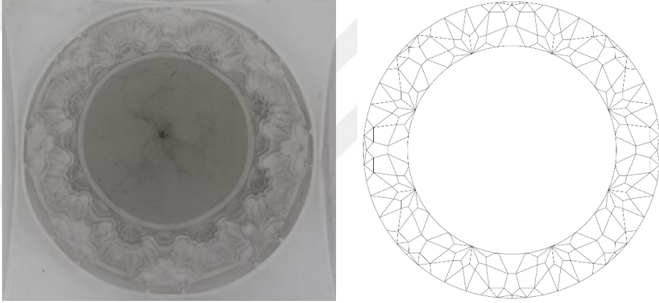
Şekil 570: Bursa Yiğit Köhne Cami'nin Son Cemaat Yerinin Orta Kubbesinin Mukarnaslı Şerit Geçişi, Solda Çizimi.
