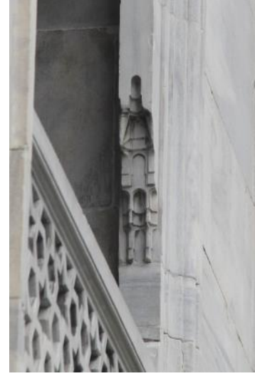
Şekil 282: Ana Cephe Balkonunun Kemer Geçişi Mukarnasının Görünümü.
