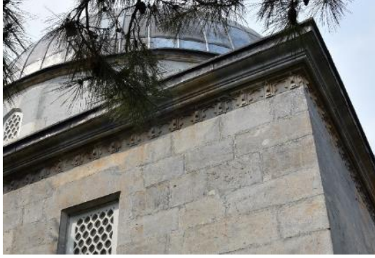
Şekil 93: Çatı Geçiş Frizi Mukarnasının Görünümü.
