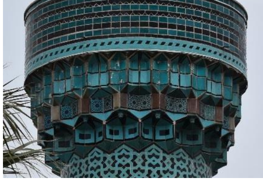
Şekil 601: İznik Yeşil Camii'nin Mukarnaslı Minare Şerefesi, Solda Çizimi.
