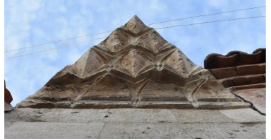
Şekil 521: Dış Duvarın Köşesi Mukarnasının Alttan Görünümü.
