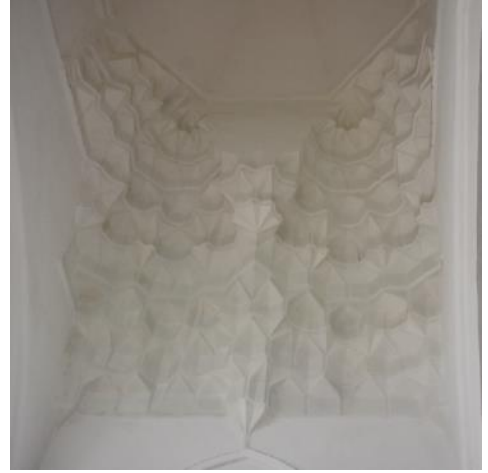
Şekil 96: Kubbe Geçişleri Mukarnasının Genel Görünümü.
