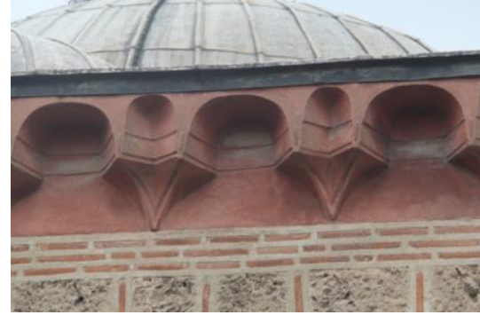
Şekil 588: İznik Mahmud Çelebi Cami'nin Çatı Geçişinde Mukarnaslı Friz, Solda Çizimi.
