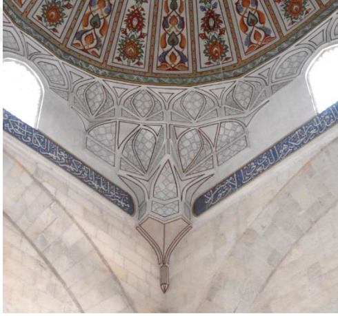
Şekil 454: Sol Ön Yan Kubbenin Geçişleri Mukarnasının Genel Görünümü.
