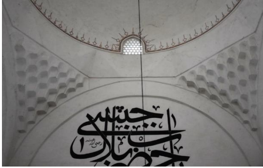
Şekil 333: Orta Kubbenin Geçiş Mukarnasının Görünümü.
