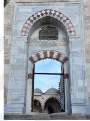
Şekil 490: Avlunun Batı Taçkapısının Genel Görünümü.
