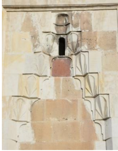
Şekil 546: Edirne Eski Cami'nin Minare Pabucunda Dekoratif Mukarnaslı Kavsara, Solda Çizimi.
