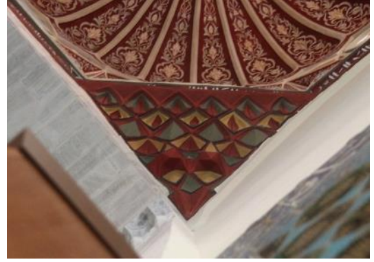
Şekil 256: Sağ Eyvanın Kubbesinin Geçiş Mukarnasının Alttan Görünümü.
