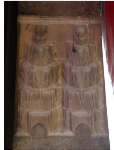
Şekil 168: Taçkapının Kemer Sağ Geçiş Mukarnasının Genel Görünümü.
