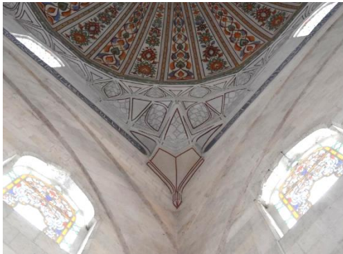
Şekil 456: Sol Ön Yan Kubbenin Geçişleri Mukarnasının Alttan Görünümü.
