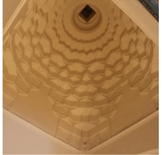
Şekil 261: Kadın Mahfilinin Kubbesi ve Geçişleri Mukarnasının Genel Görünümü.
