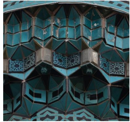
Şekil 620: İznik Yeşil Camii'nin Minaresinde Eğimli Mukarnas Elemanları.
