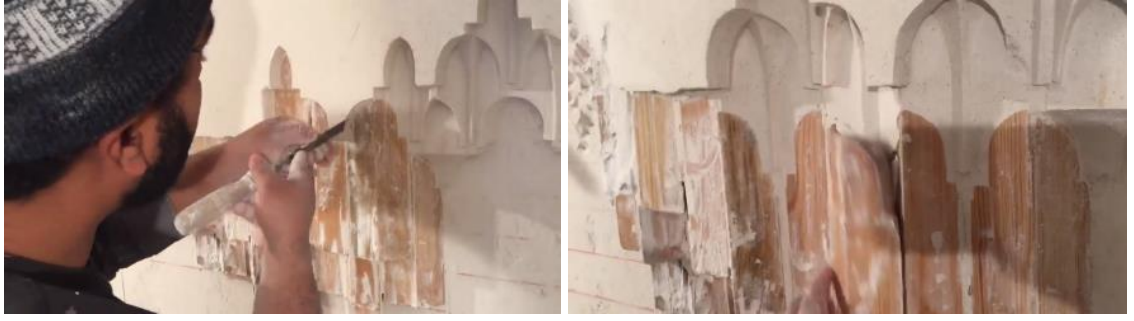
Şekil 525: Kalıplama Tekniği ile Alçılı Mukarnas, Fas Mukanası için Hala Kullanan Yöntemi (Abdelghani Nhari).
