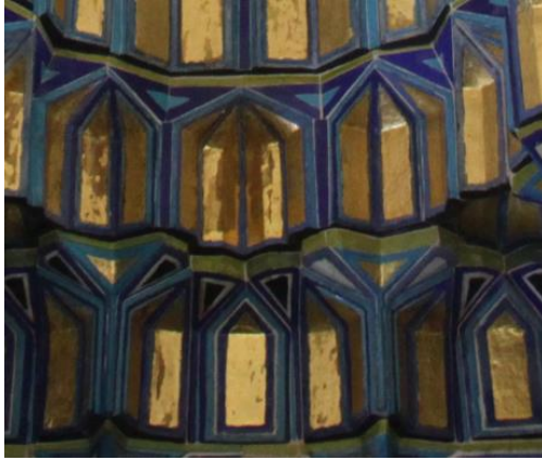
Şekil 619: Bursa Yeşil Türbe'nin Ana Mihrabında Eğimli Mukarnas Elemanları.
