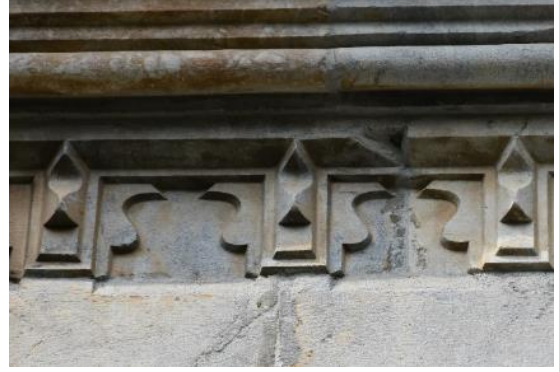
Şekil 94: Çatı Geçiş Frizi Mukarnasının Görünümü.
