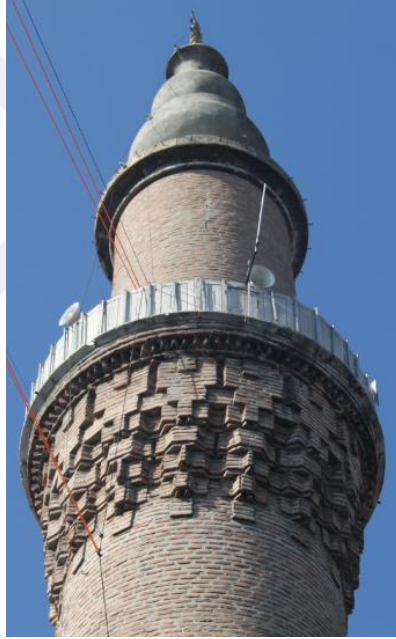
Şekil 600: Bursa Ulu Cami'nin Mukarnaslı Minare Şerefesi, Solda Çizimi.
