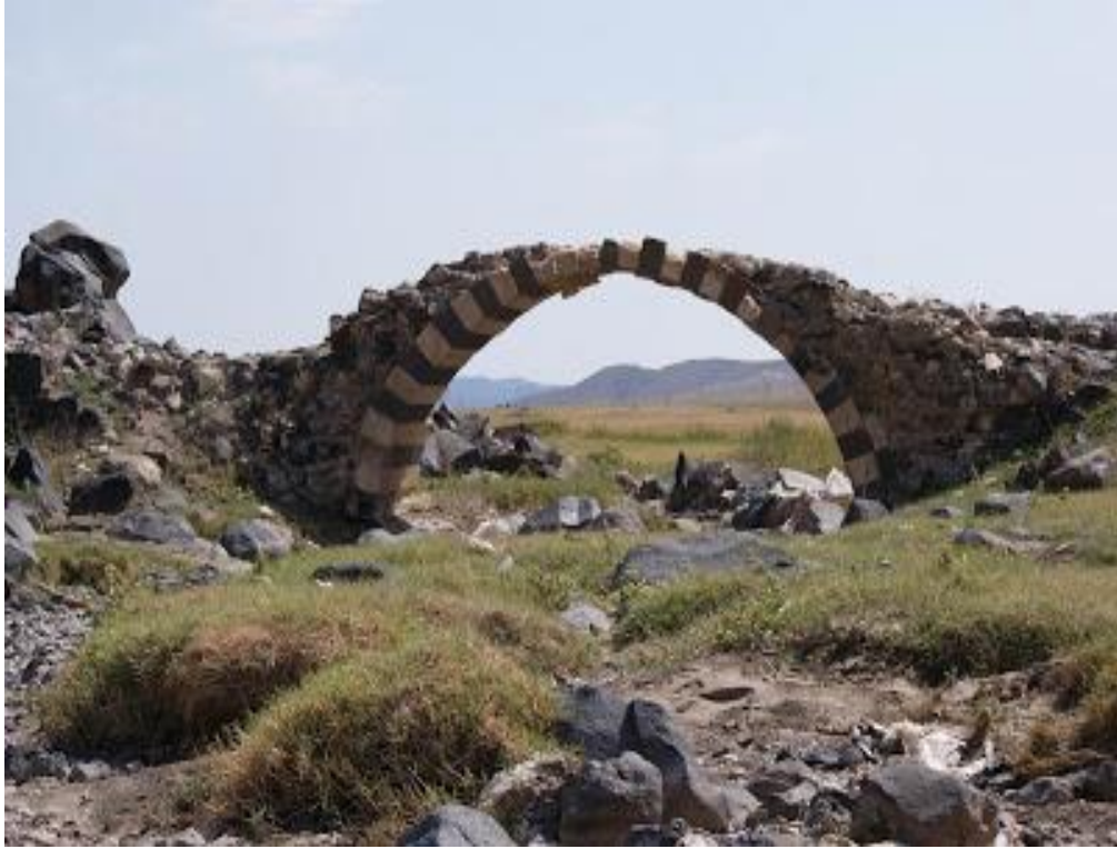
Resim 16. Pirabelek Köprüsü Eski Hali
