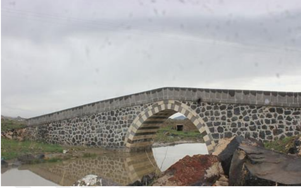
Resim 15. Pirabelek Köprüsü Yeni Hali
