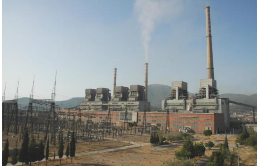
Şekil 3.4. Soma termik santrali
