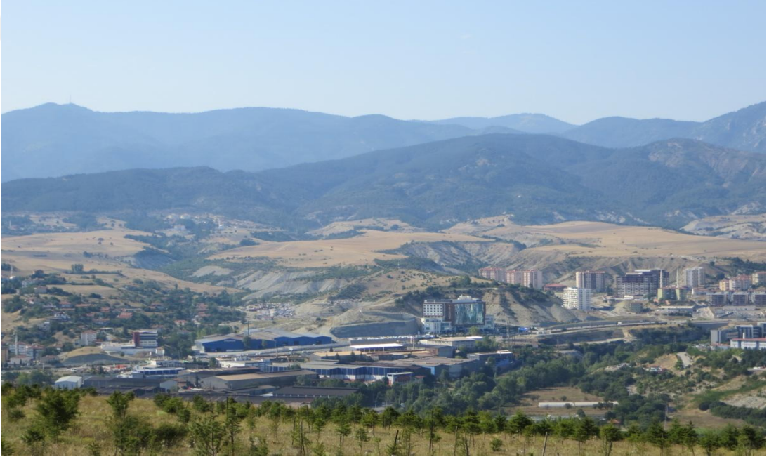
Foto 11. Araç Çayı Vadi Tabanına Yapılmış Tesis ve Konutlar.
