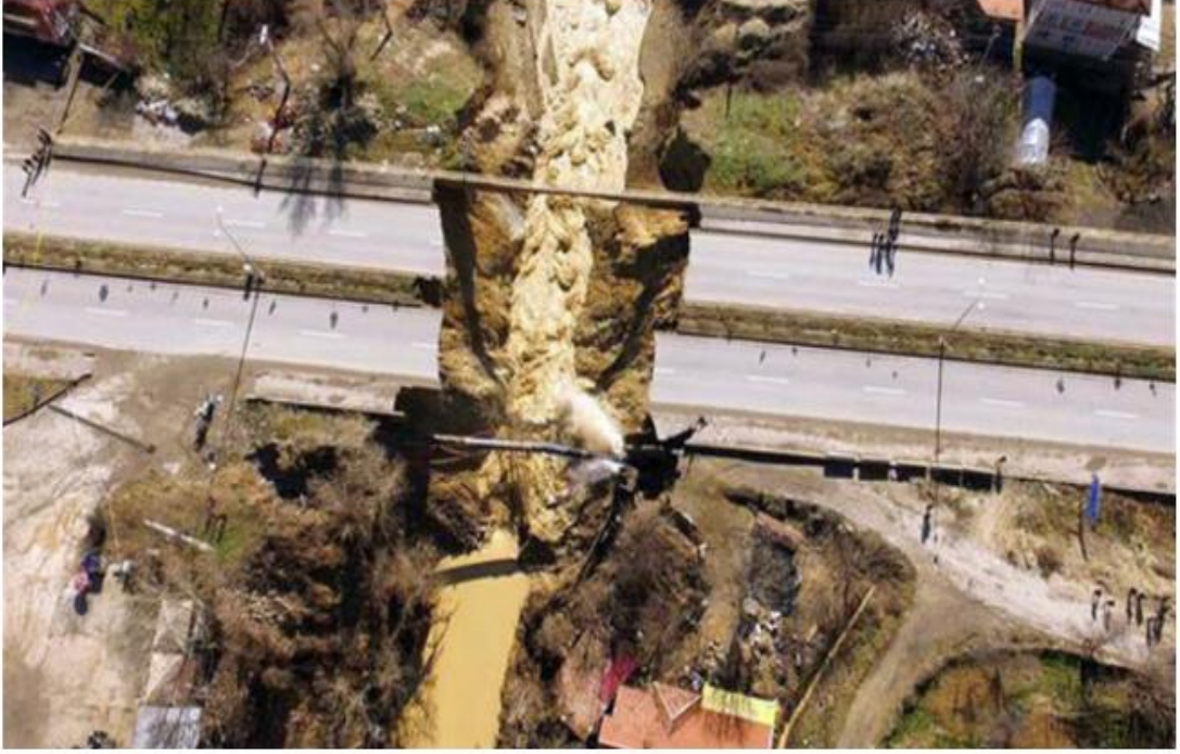
Foto 21. 2016 Yılı Şubat Ayında Karabük-Kastamonu Yolu, Bulak Deresi Üzerine İnşa Edilen Yolun Yoğun Sel Yağışı Sonucu Göçmesi.
