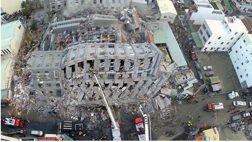
Şekil 2.4. Marmara Depremi'nin yol açtığı yıkım
