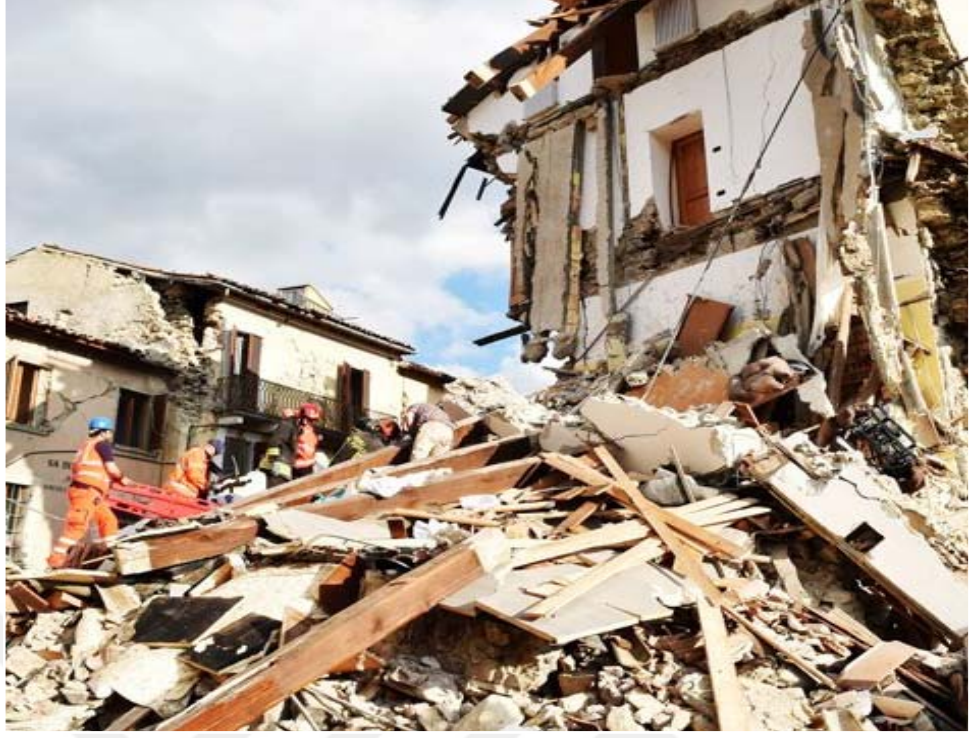
Şekil 2.7. Van Depremi'nin yol açtığı yıkım
