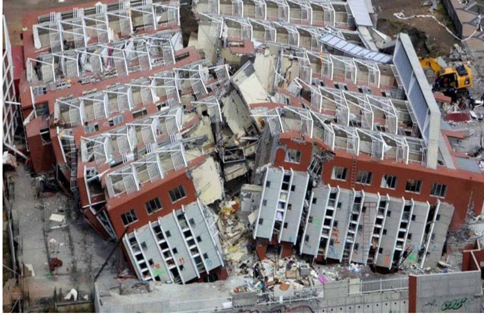
Şekil 2.5. Marmara Depremi'nin yol açtığı yıkım
