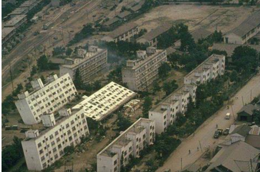
Şekil 2-5 1964 Niigata depreminde sıvılaşma sonucu yana yatmış binalar [8]
