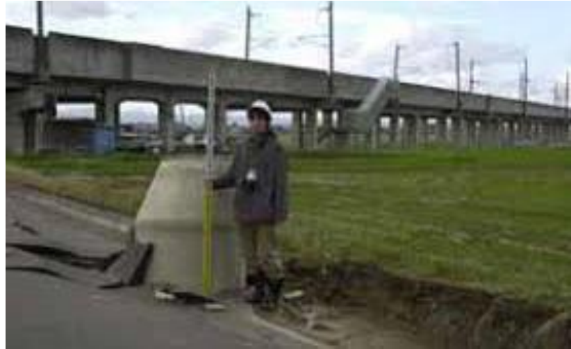
Şekil 2-7 Kanalizasyon yapılarında ortaya çıkan hasar örnekleri [10].
