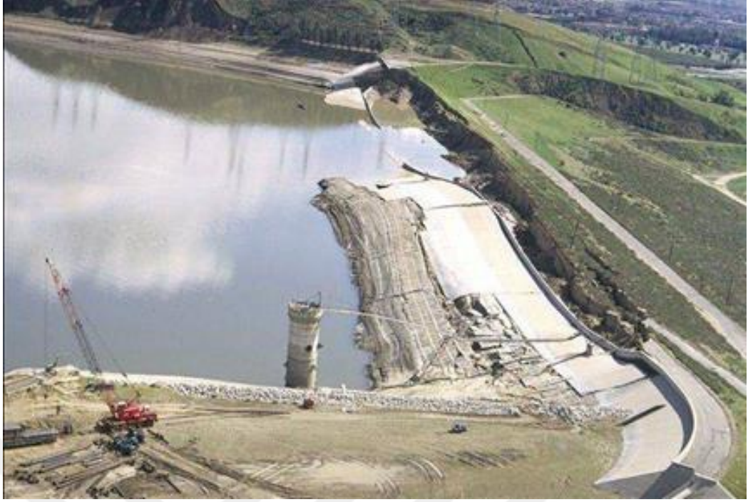
Şekil 2-9 Sıvılaşmaya bağlı olarak zeminde oturma nedeniyle 1971 san fernando depreminde hasara uğrayan san fernando barajı [11]
