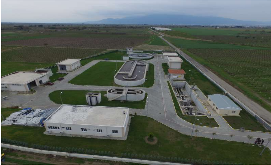
Şekil 3.1. Manisa Saruhanlı Atık Su Arıtım Tesisinin Genel Görünümü.
