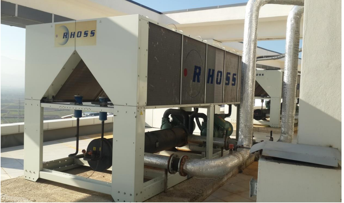
Şekil 3.4. Hava Soğutmalı Su Soğutma Grubu Gösterimi
