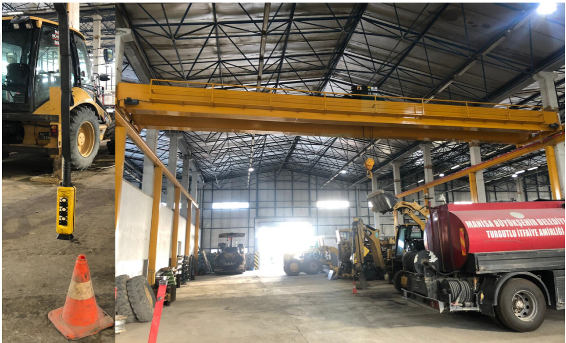
Şekil 4.4. Şantiyeden caraskal örneği ve yapılan iyileştirmelere örnek
